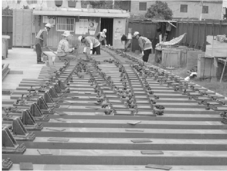
Kuva 2.21 Synteettisten vaihdepölkkyjen koeasennusta Taiwanissa (Takai et al. 2006).
