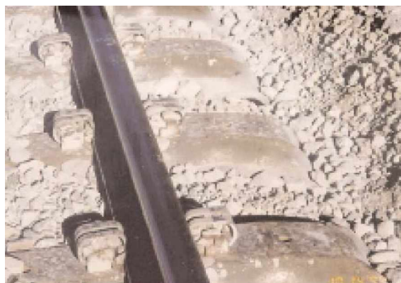
Kuva 2.18 Tukikerros jauhaantui teräsratapölkkyradalla nopeasti raiteen toistuvan pystysiirtymän seurauksena (Jimenez et al. 2000).
