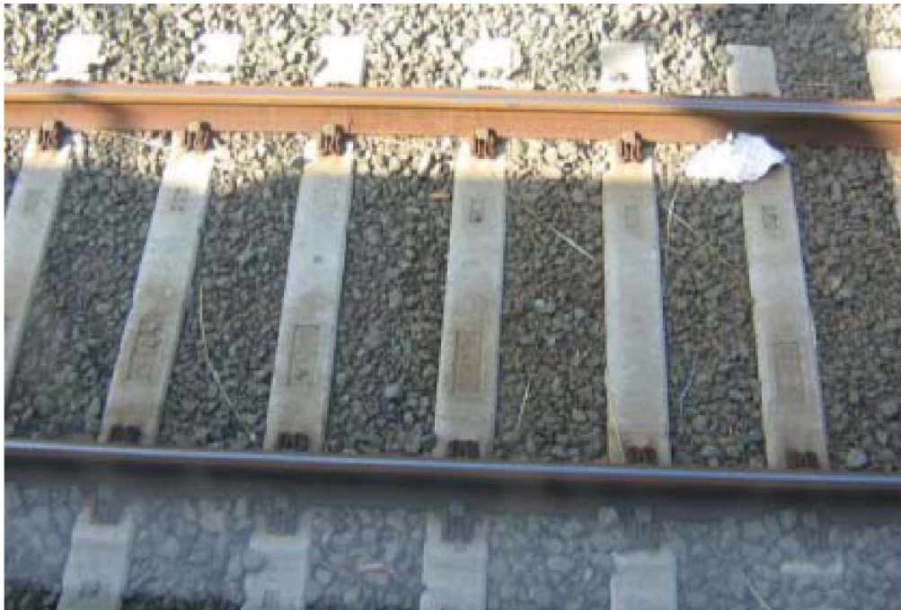
Kuva 6.16 Australiassa kehitetty puuratapölkkyjä korvaava betoniratapölkky (Manalo 2011).
