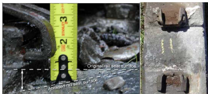
Kuva 5.16 Ratapölkyn kuluminen. Kiskon kiinnityskohta on kulunut enemmän toiselta laidalta, koska ratapölkky on sijainnut kaarteessa (Zeman et al. 2009b).
