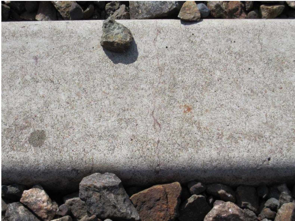
Kuva 5.2 Raiteessa oleva haljennut ratapölkky.
