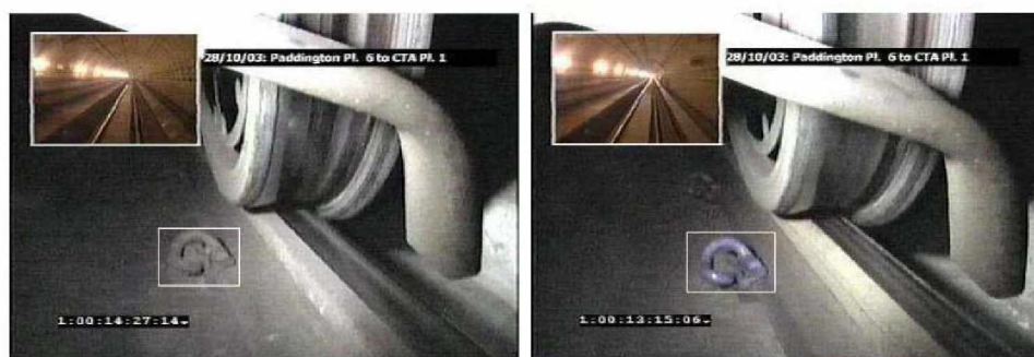
Kuva 5.21 Videokuvasta otettuja yksittäisiä kuvia. Vasemmalla vanha kiinnitysjousi ja oikealla lähes uusi kiinnitysjousi (Singh et al. 2006).
