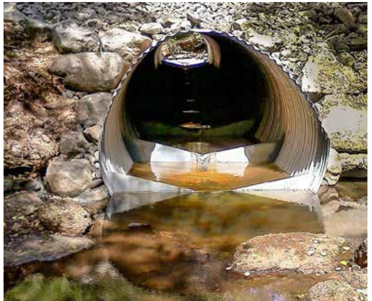
Kuva 75. Erilaisia rumpurakenteisiin asennettuja lamellirakenteita. – Skagwayn ylitysrakenteessa (Alaska, USA) on käytetty viistoja kynnykslamelleja, jotka soveltuvat 1–2,5 % kaltevuuksiin. – Alakuvissa on perinteisemmät seinästä seinään ulottuvat kynnykslamellit, joissa on loiva alivesisyvennys. Wake Creek Culvert, Blaine Road Project (Oregon, USA; alaoik) ja Midway Creek, Olympia (Washington, USA; alaoik).
