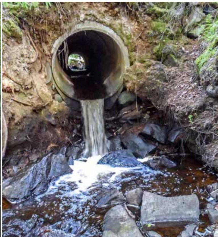
Kuva 49. Alapäästään pudottava ylitysrakenne on maamme yleisin vaellusestetyyppi. Jo muutaman sentin pudotus riittää katkaisemaan koko jokijatkumon ja aiheuttamaan merkittäviä ympäristövahinkoja.
