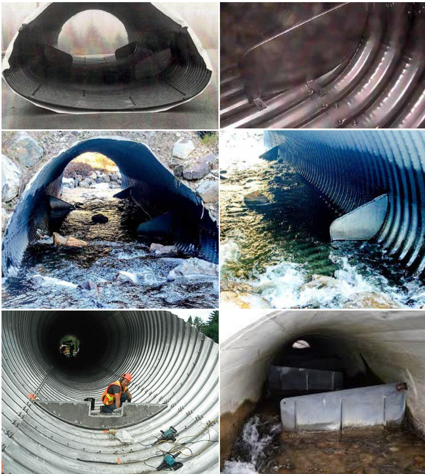
Kuva 73. Suomen ensimmäiset lamellirummut asennettiin Utsjoen puroihin. – Puksaljoen kolmilamellisen ovaalirummun suunnitteli A.Katekeetta ja valmisti Viacon Oy (ylä- ja keskikuvat). Rakenteen pohja on onnistuneesti katettu luonnonmukaisella kiveyksellä (kesvas, kesoik). Alakuvissa putken sivulle ja keskelle kiinnitetyt kynnyislamellit. Toisessa niistä (alavas) on alivesiä varten tehty kavennus.
