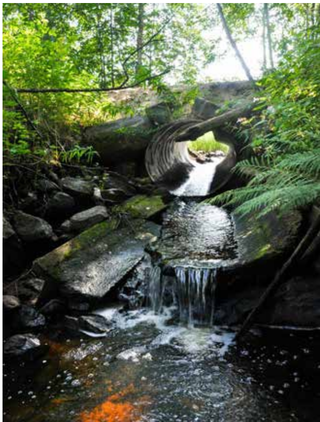
Kuva 49. Alapäästään pudottava ylitysrakenne on maamme yleisin vaellusestetyyppi. Jo muutaman sentin pudotus riittää katkaisemaan koko jokijatkumon ja aiheuttamaan merkittäviä ympäristövahinkoja.
