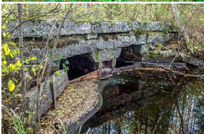
Kuva 56. Kapeat ja liian korkealle yläpäästään asennetut ylitysrakenteet kasaavat edustalleen karikepatoja, jotka aiheuttavat puolestaan virtausongelmia (yllä). – Uoman kulun peittävä tiheä kasvillisuus voi harhauttaa tai estää yläjuoksulle pyrkivien hyönteisten parveilun (keskikuvat). – Monien ylityskapeikkojen ylävirranpuolelle on rakennettu laittomia patoja yläpuolisten järvien vedenpinnan nostamiseksi (alavas). – Karikkeen keräämiseen tarkoitettu säleikkö (alaoik).
