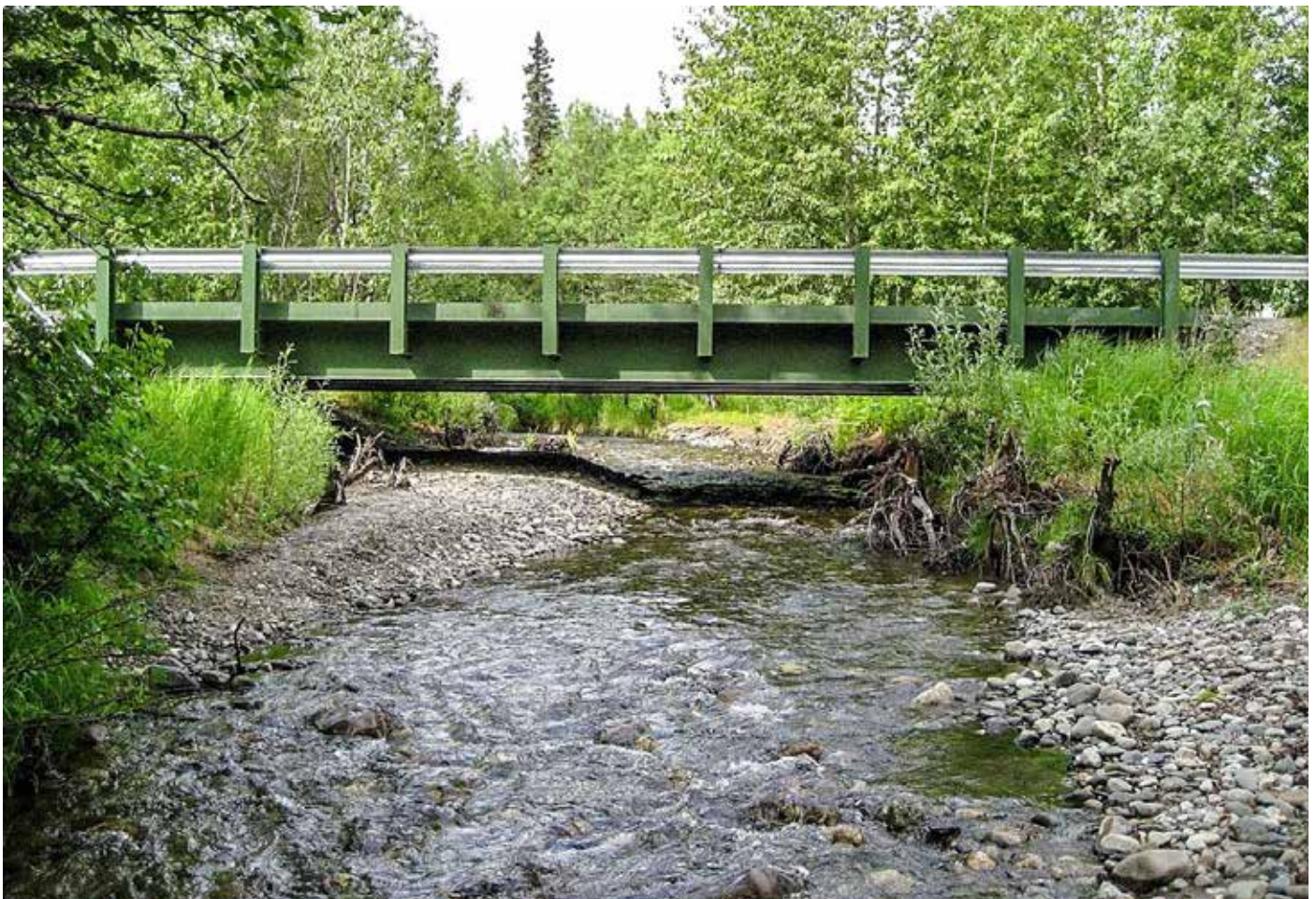
Kuva 72. Ekologisesti paras ylitysrakenne on silta tai luonnonpohjainen kaarirumpu, joka ulottuu rannalta rannalle. Swiftwater Creekissä (Alaska, USA) kolmen rummun ylitys vaihdettiin onnistuneesti siltaan.
