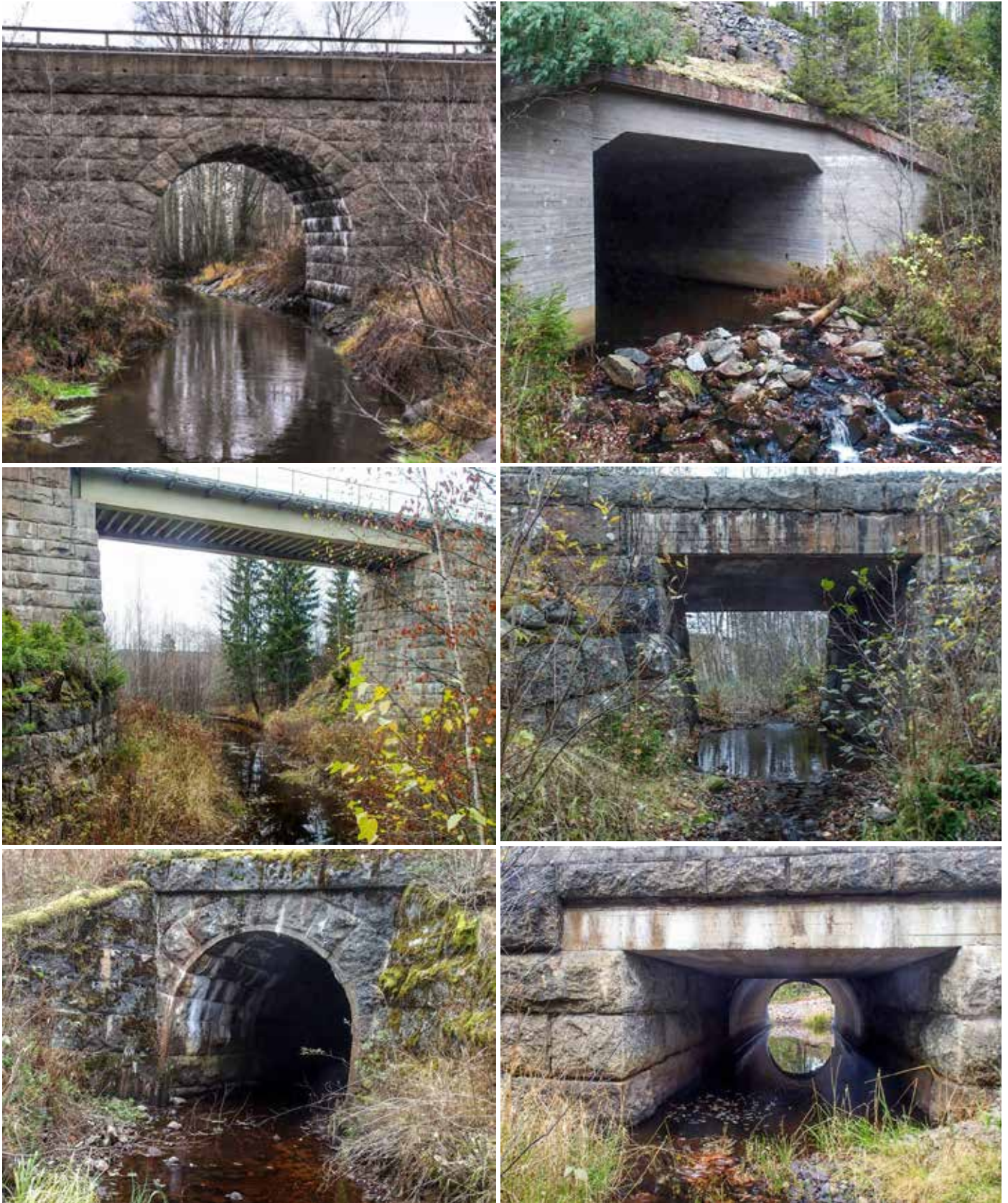
Kuva 34. Jokuoman yli rakennetut rautatiesillat ovat harvoin ekologisesti ongelmallisia. Niiden yleisin heikkous lienee kuivapolkujen puuttuminen.
