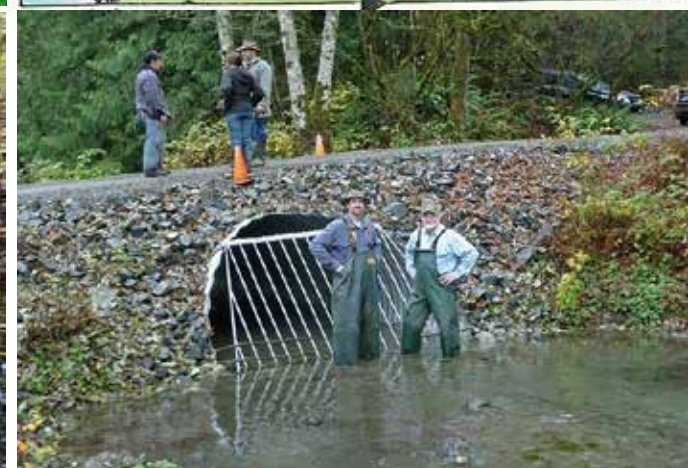
Kuva 56. Kapeat ja liian korkealle yläpäästään asennetut ylitysrakenteet kasaavat edustalleen karikepatoja, jotka aiheuttavat puolestaan virtausongelmia (yllä). – Uoman kulun peittävä tiheä kasvillisuus voi harhauttaa tai estää yläjuoksulle pyrkivien hyönteisten parveilun (keskikuvat). – Monien ylityskapeikkojen ylävirranpuolelle on rakennettu laittomia patoja yläpuolisten järvien vedenpinnan nostamiseksi (alavas). – Karikkeen keräämiseen tarkoitettu säleikkö (alaoik).
