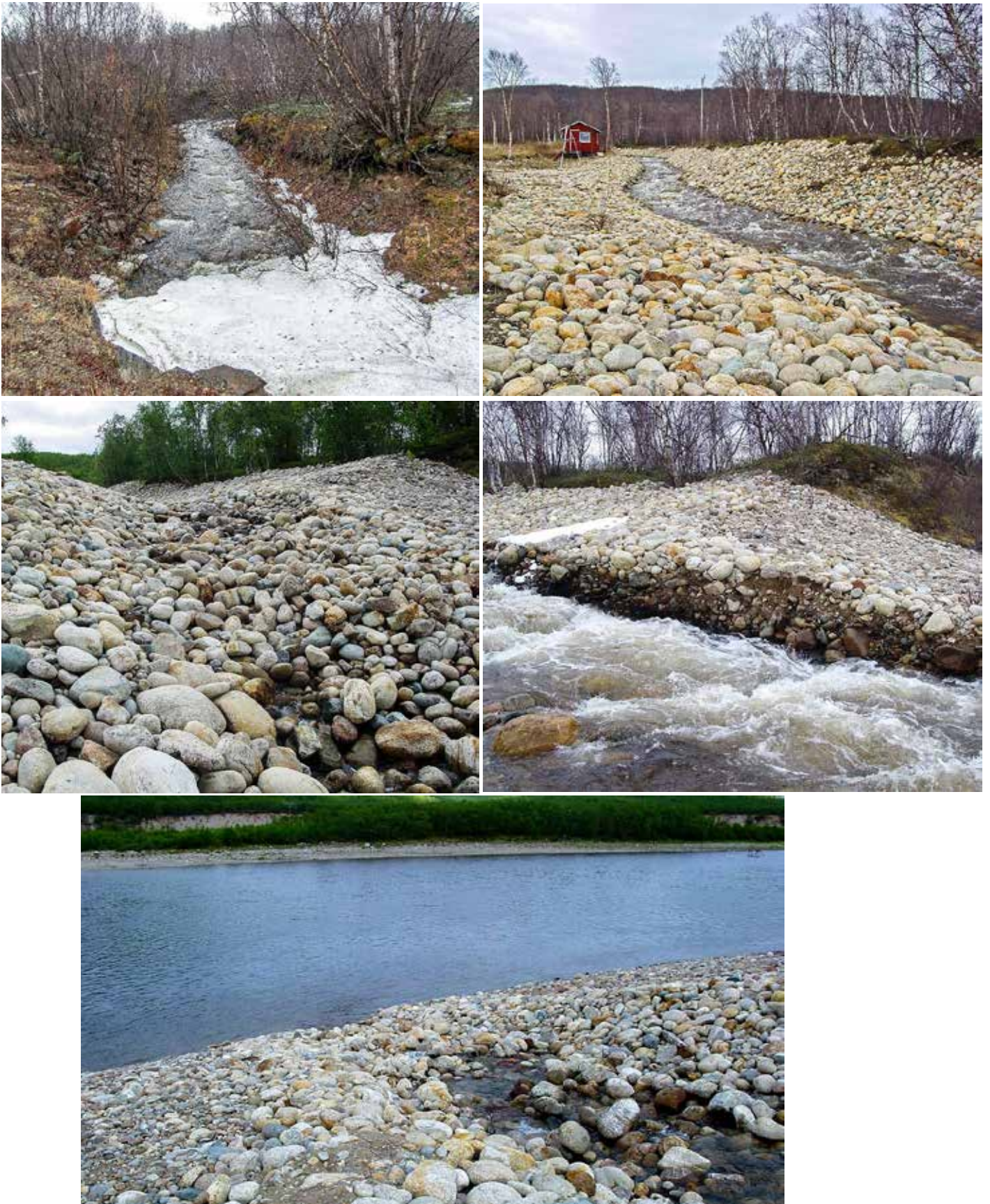
Kuva 28. Karnjargajoen (Utsjoki) epäonnistunut uomakunnostus. – Kun paantamisesta kärsinyt jokiuoma uhkasi ranta-asutusta, uomaa syvennettiin ja katettiin pyöreällä, alkuperäisestä poikkeavalla rompoolilla (yläkuvat). Toimenpide synnytti ”kuulalaakeriefektin”, joka kiihdytti eroosiota ja työnsi uuden kiviaineksen Tenojokeen (alakuvat). Nyt tämä jokisuumatalikko estää lohen- ja taimenenpoikasten pääsyn syönnösalueilleen osittain tai kokonaan.
