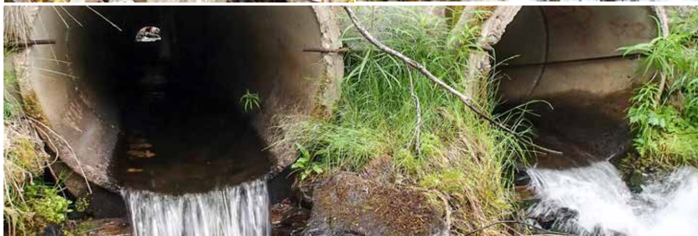
Kuva 12. Utsjoen virtavesien ylitykset olivat aiemmin yleensä hirsirakenteisia, ympäristöystävällisiä puusiltoja (yllä). Rumpujen perustamiset synnyttivät monia vaellusesteitä tai -hidasteita (keskellä). Vuolit Boratbokcákajoen rumpurakenteet estivät aluksi täydellisesti lohikalojen poikasvaellukset Tenojoesta, mutta kunnostustoimenpiteiden jälkeen vaelluseste on enää ajottainen (alakuva). Figure 12. First crossing constructions in the Utsjoki commune were ecologically friendly wooden bridges (above left), which saved the natural river bottom. Constructions of round culverts created several migration barriers or drags (middle). The culverts in the Vuolit Boratbokcáka tributary were first total barriers for fish migrations, but after some restoration measures they became passable during favourable water conditions (below).
