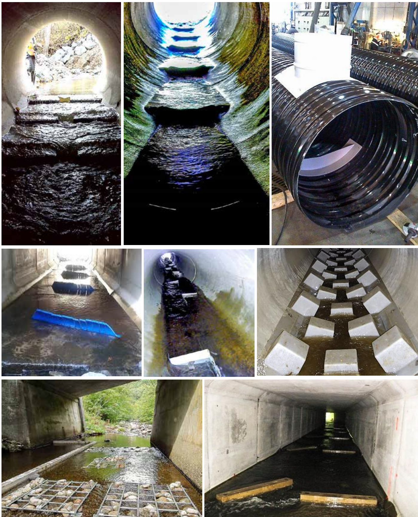
Kuva 76. Erilaisia rumpurakenteisiin asennettuja lamellirakenteita. – Kynnyslamelliratkaisuja Sawmill Riverissä (Dartmouth, Kanada; ylävas), Uudessa Seelannissa (ATS Environmentalin malleja; yläkes, kesvas, keskes)) ja ViaConin tehtaalla (Helsinki; yläoik). – Ohjainlamelleja MacLean Creekissä (Alberta, Kanada; kesoiik), ulokelamelleja Nod Brookkissa (Simsbury, USA; alaoik) sekä Sandy Creekin kivi-harjateräs-rakenteita (Connecticut, USA; alavas). Viimeksi mainittu on kehitetty betonipohjaisia, vähävetisiä uomia varten. Huomaa pohjaan tehty alivesikavennus.
