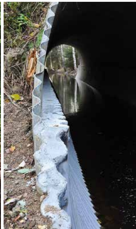
Kuva 67. Ns. sujutuskorjaus on yleistynyt etenkin teräksisten rumpurakenteiden korjauksessa. Yleensä uusittava puolipohja sovitetetaan vanhan putken sisään ja betonoidaan siihen kiinni. Ennen korjaustoimenpiteitä on varmistettava, ettei kaventamisella heikennetä rakenteen vedenjohtokykyä. – Esimerkki uuden putken väärästä asentamistavasta (alavas), asianmukaisesti tehty putken puolipohjaus (yllä, alakes) ja vastikään sujutettu puolipohja ohjausketjuineen (alaoik).
