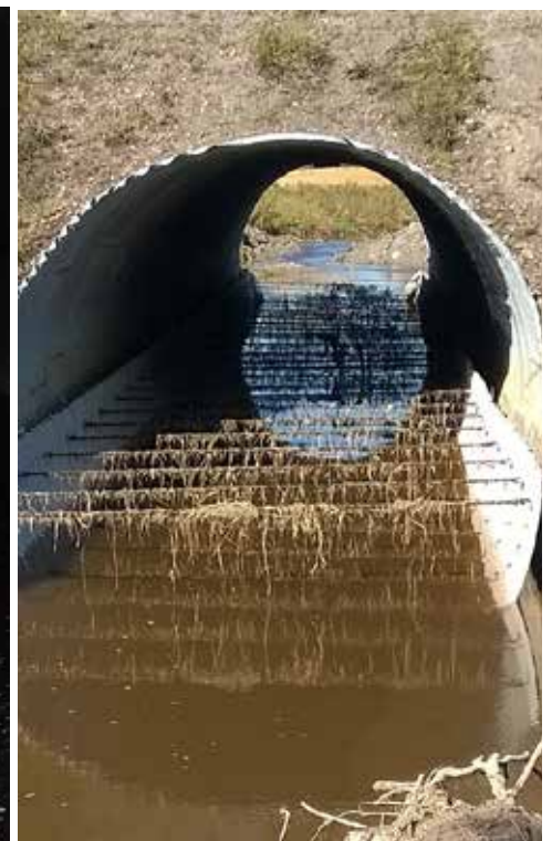
Kuva 67. Ns. sujutuskorjaus on yleistynyt etenkin teräksisten rumpurakenteiden korjauksessa. Yleensä uusittava puolipohja sovitetetaan vanhan putken sisään ja betonoidaan siihen kiinni. Ennen korjaustoimenpiteitä on varmistettava, ettei kaventamisella heikennetä rakenteen vedenjohtokykyä. – Esimerkki uuden putken väärästä asentamistavasta (alavas), asianmukaisesti tehty putken puolipohjaus (yllä, alakes) ja vastikään sujutettu puolipohja ohjausketjuineen (alaoik).
