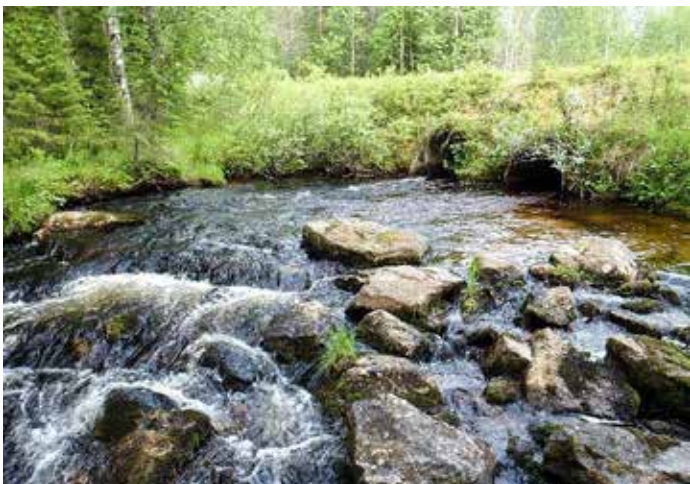
Kuva 71. Monessa tapauksessa rumpurakenteen alapään pudotusongelma voidaan poistaa tai vähentää rakentamalla matalia, koskimaisia pohjakynnyksiä lähestymisalueelle. Kynnysten määrä riippuu uoman kaltevuudesta ja maaperäolosuhteista. – Vuolit Boratbokcájoen (Utsjoki) ylityksen ala-allas on vielä liian matala (yllä). – Kaavakuva kynnysrakentamisen periaatteesta (kesk) mukailtu Degermanin (2008) mukaan. – Säkkisenojan (Taivalkoski) ja Kyrönpuron (Viitasaari) kunnostetut lähestymisalueet (alla). Figure 71. In many cases the culvert outlet drop can be removed or decreased by building low, rapid-like low-head weirs close to the culvert mouth. The number of low-head weirs needed depend on the channel slope and soil structure. – The outlet drop of the Vuolit Boratbokcájoen (Utsjoki) culverts is still too high. – A schematic illustration of low-head weirs (middle) following Degerman (2008) – The restored culvert mouths in Säkkisenoja (Taivalkoski) and Kyrönpuro (Viitasaari) (below).
