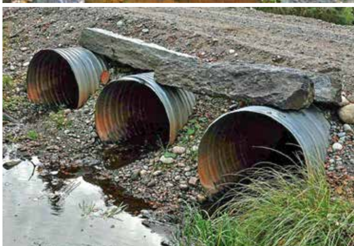
Kuva 38. Useimmat monirumpurakenteet ovat ympäristöllisesti huonoja ratkaisuja. Kestävässä monirumpuratkaisussa putket asetetaan päällekkäin, ei rinnakkain (alaoik). Ylempi putki johtaa tulvavedet ja alempi toimii vesieläinten läpikulku-uomana. Ovaalirumpu (yllä) sopii huonost vähävetisille valuma-alueille, koska se juokuttaa vettä eniten juuri kriittisenä alivesikautena.
