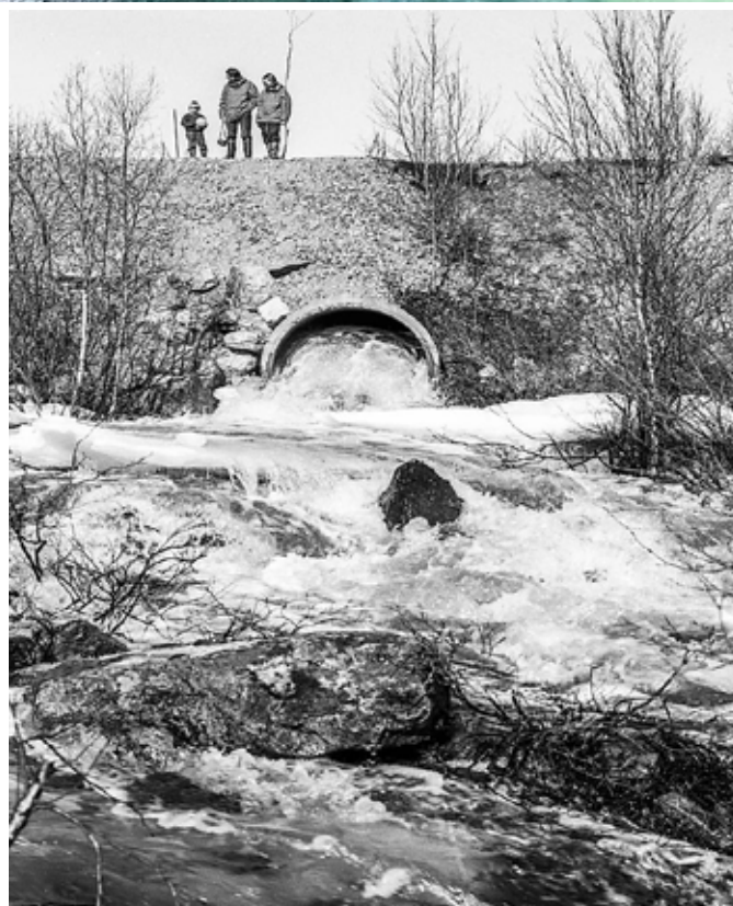
Kuva 58. Siltojen korvaaminen liian kapeilla rumpurakenteilla pahensi selvästi vesistöilysten jää- ja tulvaongelmia. Tukkeutuneen kohdan avaaminen höyrysulatuksella tai konekaivuulla vaurioittaa helposti vesieliöstöä ja niiden elinympäristöjä.
