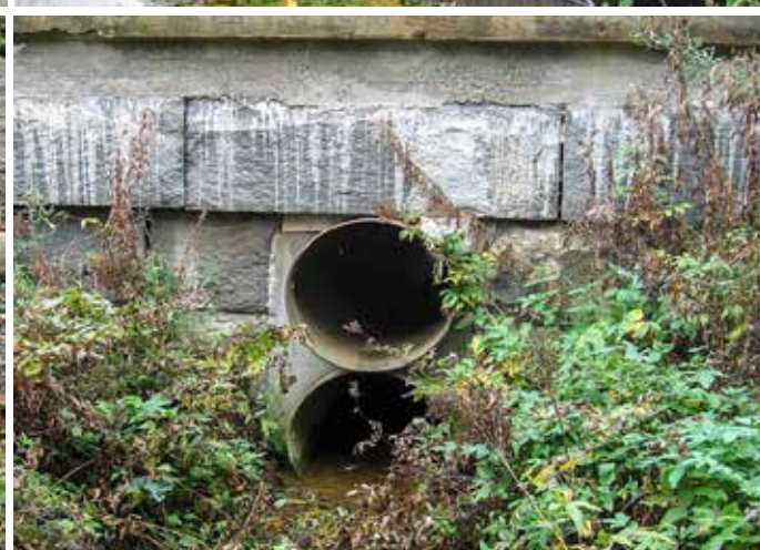
Kuva 38. Useimmat monirumpurakenteet ovat ympäristöllisesti huonoja ratkaisuja. Kestävässä monirumpuratkaisussa putket asetetaan päällekkäin, ei rinnakkain (alaoik). Ylempi putki johtaa tulvavedet ja alempi toimii vesieläinten läpikulku-uomana. Ovaalirumpu (yllä) sopii huonost vähävetisille valuma-alueille, koska se juokuttaa vettä eniten juuri kriittisenä alivesikautena.
