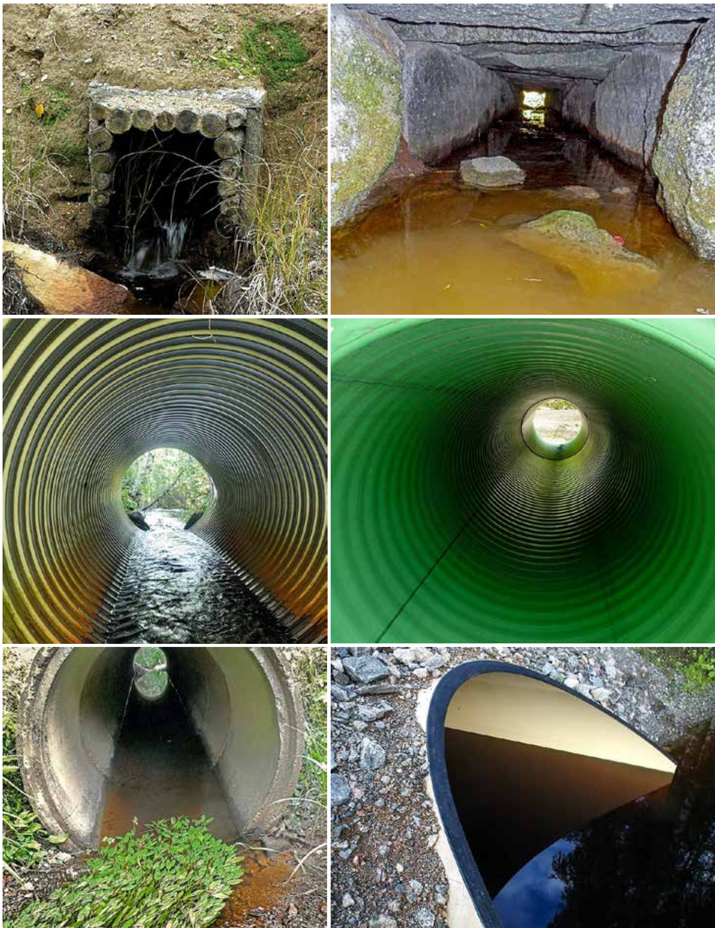
Kuva 37. Erilaisia rumpumateriaaleja. – Puu-, lohkokivi-, metalli-, muovi-, betoni- ja komposiittirumpu.
