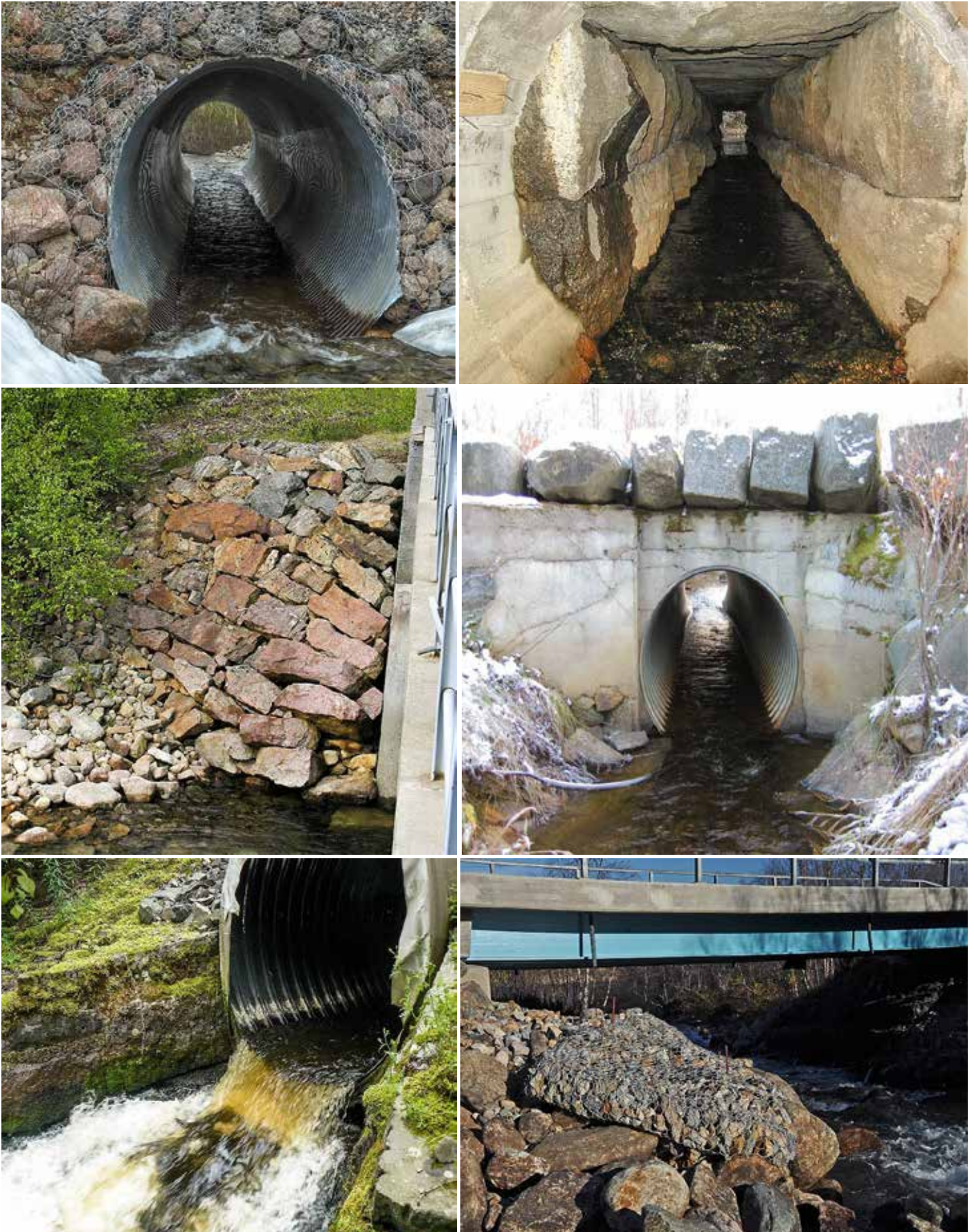
Kuva 66. Ylitusrakenteen pääty- ja sivuluiskilla on sekä teknistä että esteettistä merkitystä. Luiskien suojaamisessa on monia vaihtoehtoja. – Kivikorisuojuukset (ylävas ja alaoik) aiheuttavat helposti maisemavaurioita. – Luonnonkivien käyttö (kesoik) päätyluiskassa vaatii huolellista latomista ja tiivistämistä. – Rautateiden lohkokiviylityksiä on monessa paikassa pidennetty erilaisilla jatkoksilla (yläoik).
