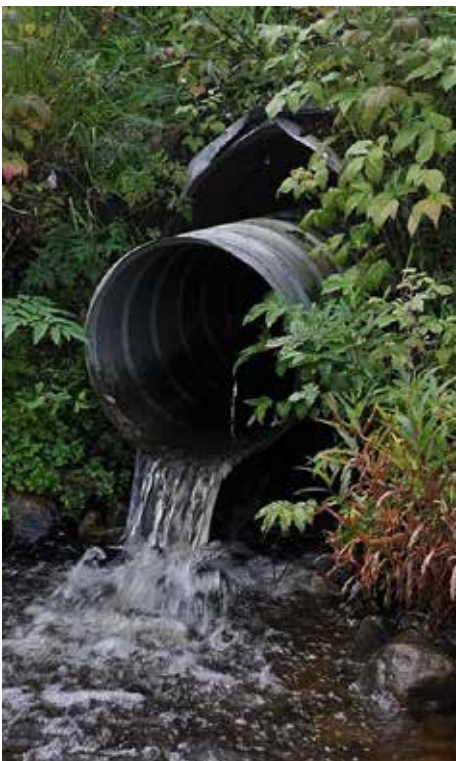
Kuva 67. Ns. sujutuskorjaus on yleistynyt etenkin teräksisten rumpurakenteiden korjauksessa. Yleensä uusittava puolipohja sovitetetaan vanhan putken sisään ja betonoidaan siihen kiinni. Ennen korjaustoimenpiteitä on varmistettava, ettei kaventamisella heikennetä rakenteen vedenjohtokykyä. – Esimerkki uuden putken väärästä asentamistavasta (alavas), asianmukaisesti tehty putken puolipohjaus (yllä, alakes) ja vastikään sujutettu puolipohja ohjausketjuineen (alaoik).
