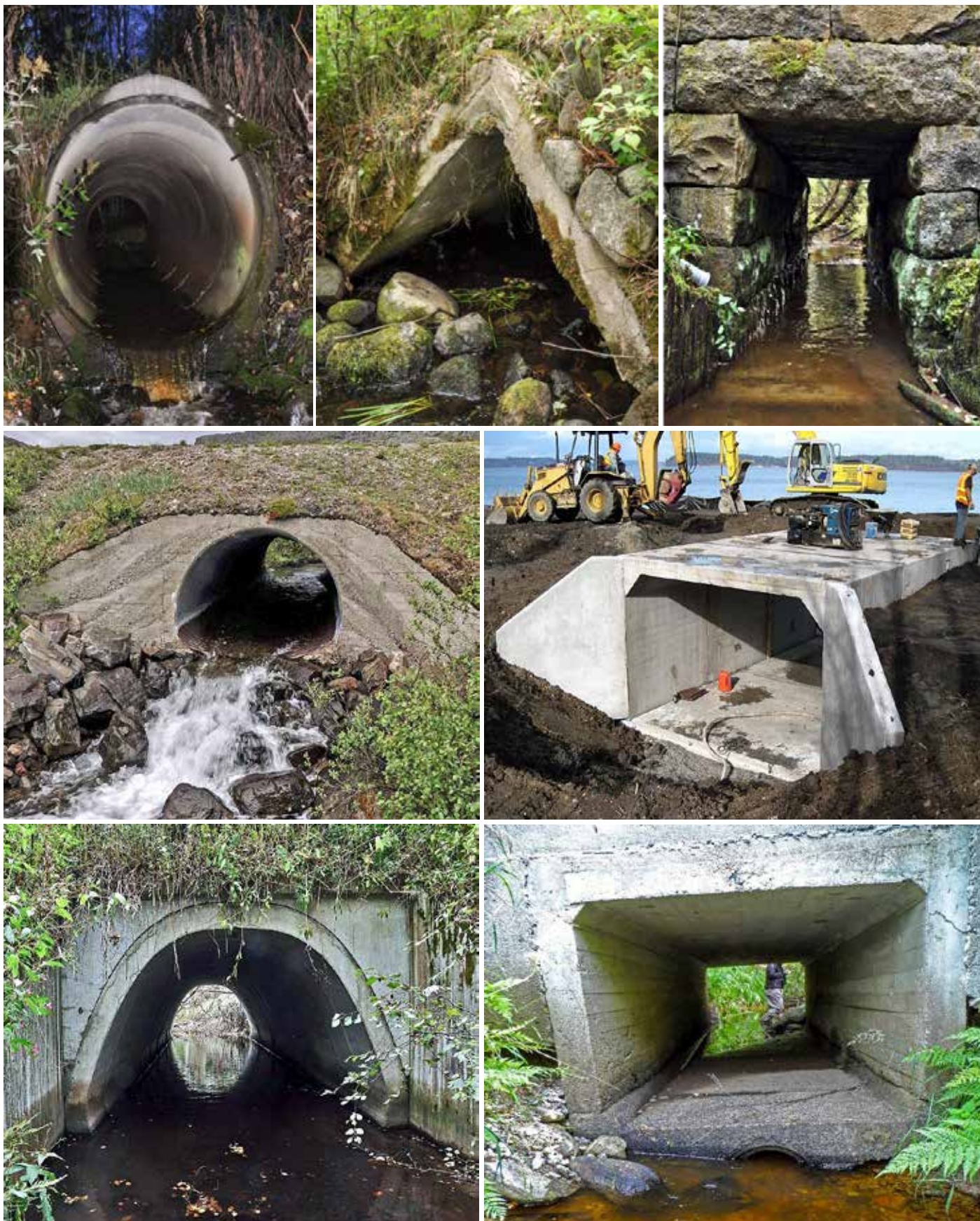
Kuva 36. Muodon perusteella nimettyjä umpurakennetyyppejä. – Pyöreä betonirumpu lienee maailman yleisin umpurakenne (ylävas). Seuraavissa kuvissa on kolmikulmainen, suorakaiteenmuotoinen, ovaali-, laatikko-, kaari- ja neliskulmainen rumpu.
