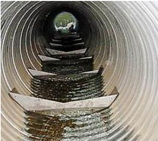
Kuva 75. Erilaisia rumpurakenteisiin asennettuja lamellirakenteita. – Skagwayn ylitysrakenteessa (Alaska, USA) on käytetty viistoja kynnykslamelleja, jotka soveltuvat 1–2,5 % kaltevuuksiin. – Alakuvissa on perinteisemmät seinästä seinään ulottuvat kynnykslamellit, joissa on loiva alivesisyvennys. Wake Creek Culvert, Blaine Road Project (Oregon, USA; alaoik) ja Midway Creek, Olympia (Washington, USA; alaoik).
