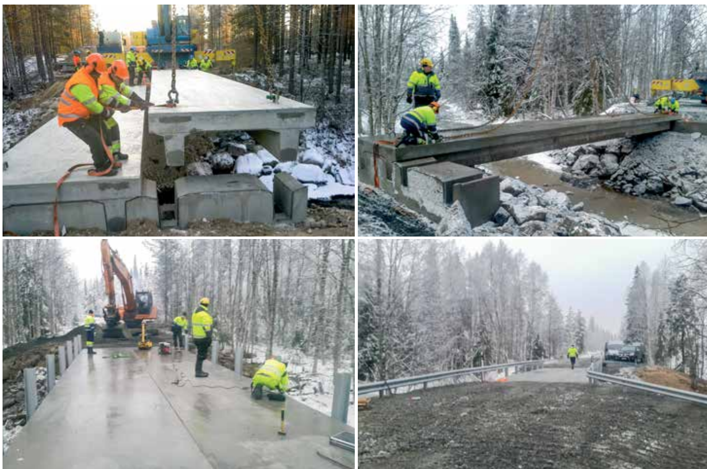
Kuva 64. Metsähallitus näytti ympäristöllisesti hyvää esimerkkiä korvattessaan Katuojan (Rovaniemi) vanhan liimapalkkisillan uudella betonisella laattasillalla. Vanhan sillan puukansi siirrettiin uusiokäyttöön toiselle ylityskohteelle. Liian usein vanhoja, hyvin perustettuja piensilloja korvataan ympäristöllisesti huonoilla umpirummuilla.
