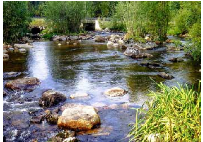
Kuva 71. Monessa tapauksessa rumpurakenteen alapään pudotusongelma voidaan poistaa tai vähentää rakentamalla matalia, koskimaisia pohjakynnyksiä lähestymisalueelle. Kynnysten määrä riippuu uoman kaltevuudesta ja maaperäolosuhteista. – Vuolit Boratbokcájoen (Utsjoki) ylityksen ala-allas on vielä liian matala (yllä). – Kaavakuva kynnysrakentamisen periaatteesta (kesk) mukailtu Degermanin (2008) mukaan. – Säkkisenojan (Taivalkoski) ja Kyrönpuron (Viitasaari) kunnostetut lähestymisalueet (alla). Figure 71. In many cases the culvert outlet drop can be removed or decreased by building low, rapid-like low-head weirs close to the culvert mouth. The number of low-head weirs needed depend on the channel slope and soil structure. – The outlet drop of the Vuolit Boratbokcájoen (Utsjoki) culverts is still too high. – A schematic illustration of low-head weirs (middle) following Degerman (2008) – The restored culvert mouths in Säkkisenoja (Taivalkoski) and Kyrönpuro (Viitasaari) (below).
