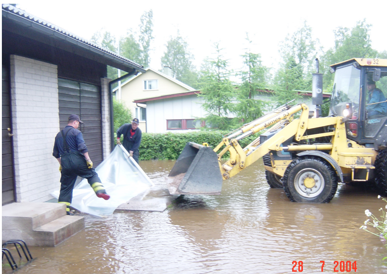
Kuva 6.3. Kiinteistön suojausta Riihimäellä. (Kanta-Hämeen pelastuslaitos 2004)
