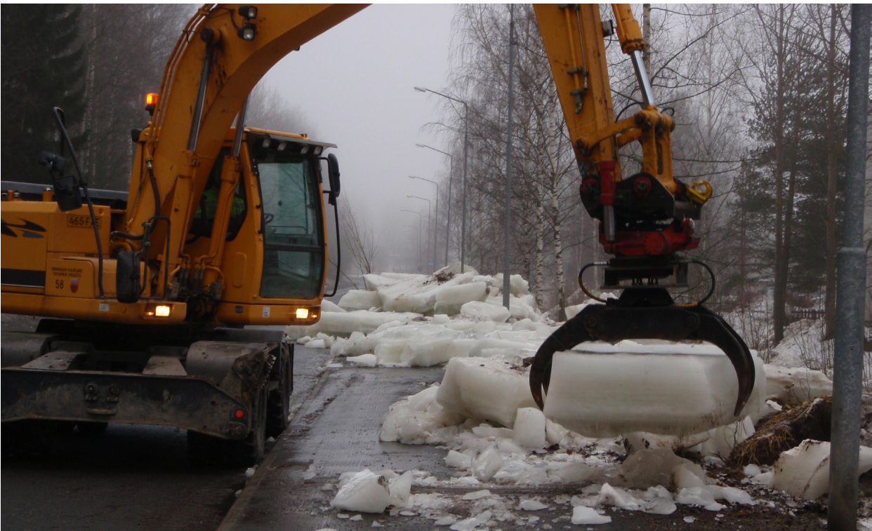
Kuva 10.2. Jään poistoa Vantaanjoesta ennen kevättulvaa. (Riihimäen kaupunki 2011)
