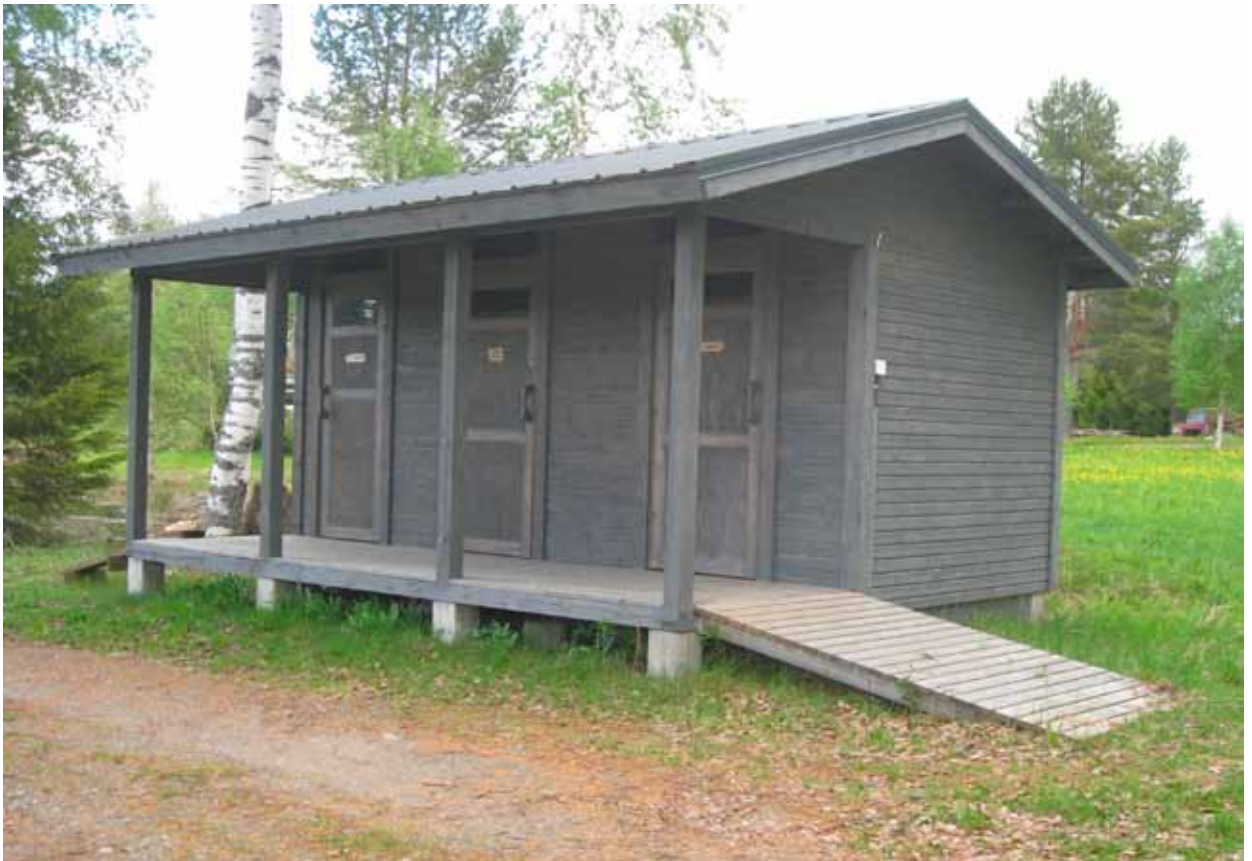
Kuva 17 Kallioniemen venesatama, varasto- ja wc-rakennus
