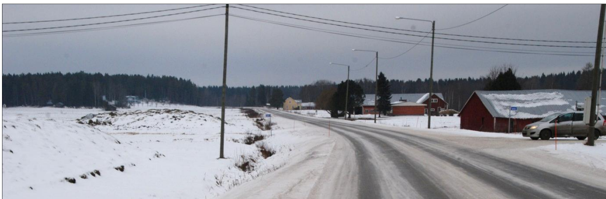
Kuva 10. Slipin risteys, jossa valaistus Lillbyn puoleisessa päässä loppuu, tästä pohjoiseen on n. 1,5 km ilman valaistusta.
