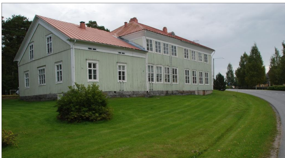
Kuva 7. Vanha tyhjillään oleva koulu, joka tullaan purkamaan kevyen liikenteen väylän alta.
