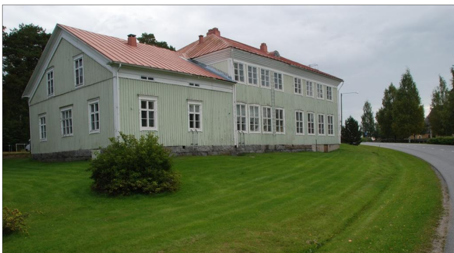
Bild 7. När den gamla skolan rivs kan man bygga en gång- och cykelled.
