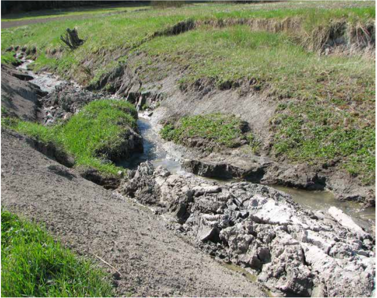
Perinteinen perkaus Kemiönsaarella on epäonnistunut sortuvan maaperän vuoksi. Kuva: Anni Karhunen
