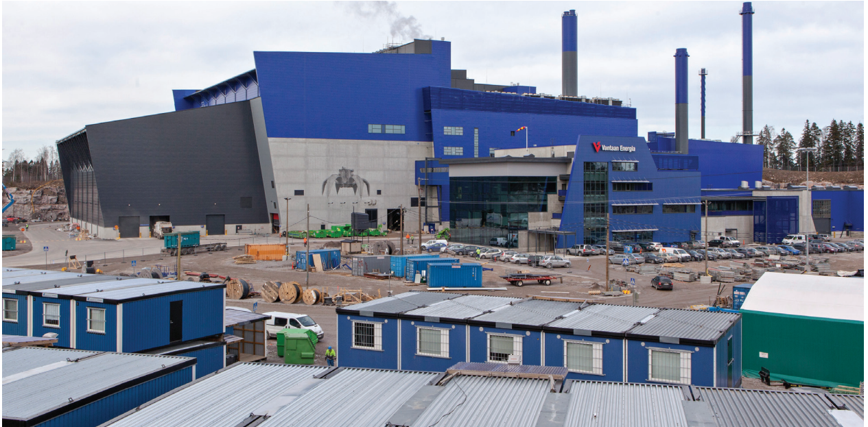
Kotitalousjätteet muuttuvat lämmöksi ja sähköksi monin paikoin kaatopaikalle viemisen sijasta. Kuvassa on Vantaan Energia Oy:n jätevoimala, joka tuottaa energiaa pääkaupunkiseudun yhdyskuntajätteistä vuodesta 2014 lähtien. [Kuva Vantaan Energian kuva-arkisto]
