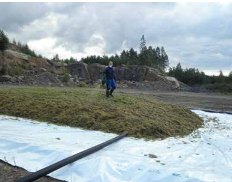
Auman pintaan levitettiin AIV-liuosta. Suotovesiä varten asetettiin alimpaan kohtaan poistoputki. Kuva: Ritva Kemppainen
