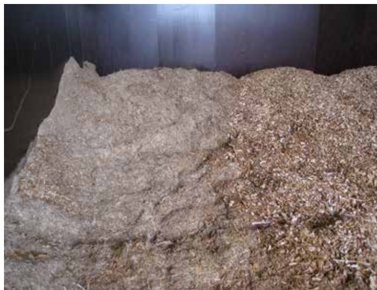
Silputtua talviruokoa ja puuhaketta Taivassalon lämpölaitoksen varastossa. Tankopurkaimet siirtävät polttoaineen varastosta kokoojaruuville (kasojen takana), josta se siirretään edelleen nosto- ja pesäruuveilla kattilaan. Ruokosilpun siirtämisessä ei ollut ongelmia, koska silppu oli riittävän lyhyttä (2-5 cm). Kuva: Terhi Ajosenpää
