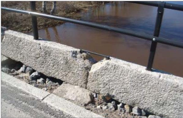
Sillan ulkonäkö muuttui korotettujen kaiteiden takia. Sillan kannen kuivatusjärjestelmä näyttää omituiselta museaalisessa näkökulmassa ja alentaa sillan alkuperäisyyden sekä museointihetken aitoa säilyneisyyttä. Kuitenkin sillan rakenteen kuvaamiseksi ja siten säilymsedellelysten paraneminen kautta ne ovat perustellut. Kuva Martti Piltz
