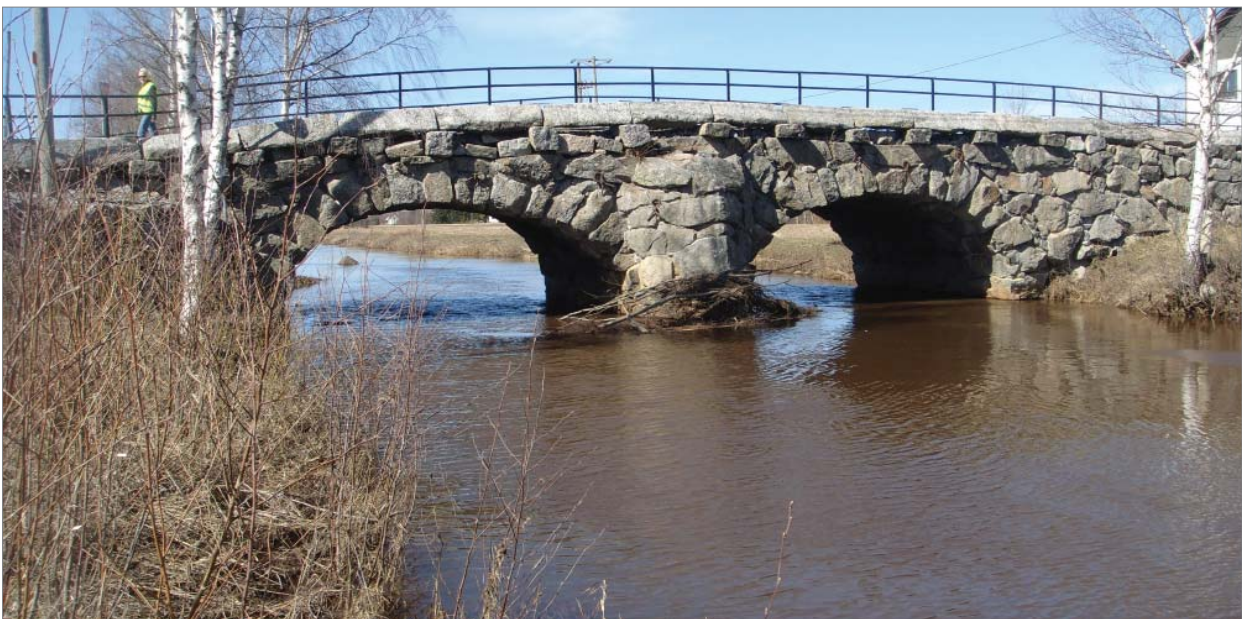
Pajukko valtaa nopeasti sillan ympäristön, joten sitä on raivattava riittävän usein. Kuva Martti Piltz.
