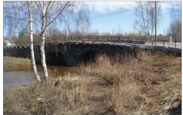
Sillan kaiderakennelmat ovat hyväksyttävissä niiden turvallisuutta parantavan vaikutuksen takia. Ne ovat museaalisestakin näkökulmasta myös niin poikkeavat sillan alkuperäisestä rakenteesta, että ne voi tulkita erillisiksi lisärakenteiksi. Kuva Martti Piltz
