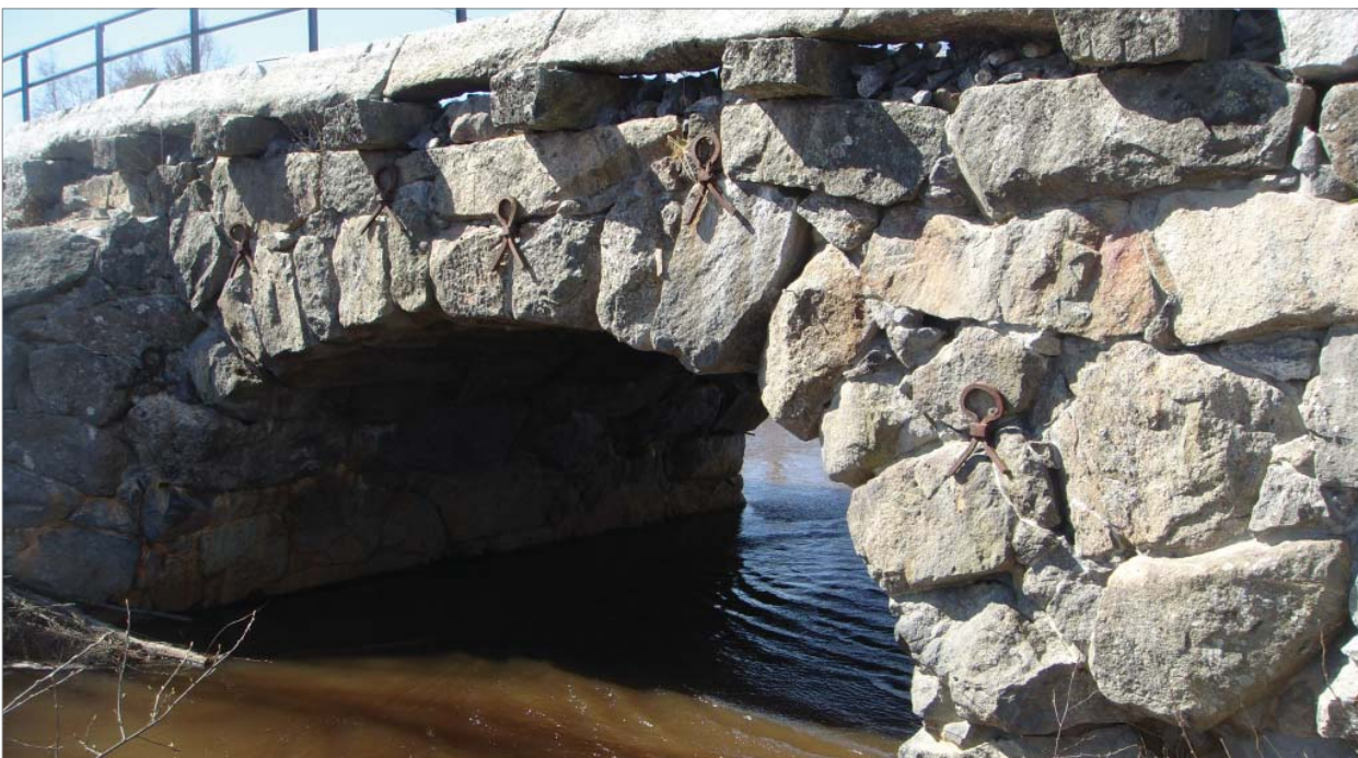
Eteläisen sillan pohjoisen puoleinen holvi näyttää remontin jäljiltä hyväkuntoiselta. Kivien saumoihin injektoitu sementti on tässä siistin näköinen. Sideraudat on lisätty sillan jonkun remontin yhteydessä aikaisemmin. Sillan kuvauksissa mainitaan, että alunperin sillalla ei ole ollut mitään rautasiteitä. Kuva Laura Soosalu
