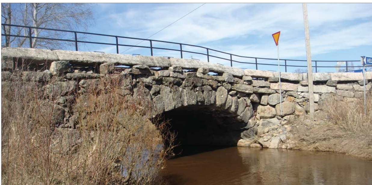
Pohjoispuoleisessa haarassa silta on yksiaukkoinen. Kuva Martti Piltz
