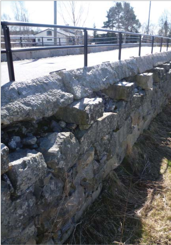
Sillalle on vuoden 2010 kunnostuksen yhteydessä rakennettu kaiteet. Kaiteen korotusosa on kuumasinkittyä terästä ja maalattu mustaksi. Kuva Laura Soosalu
