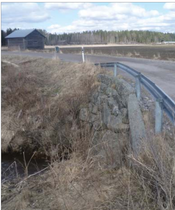
Vanha luonnonkivistä rakennettu rumpu ylittää Fjärdsbäckenin tien mutkakohdassa. Alkuperäinen, Suomen sodan aikainen silta ei ole säilynyt. Kuva Laura Soosalu.
