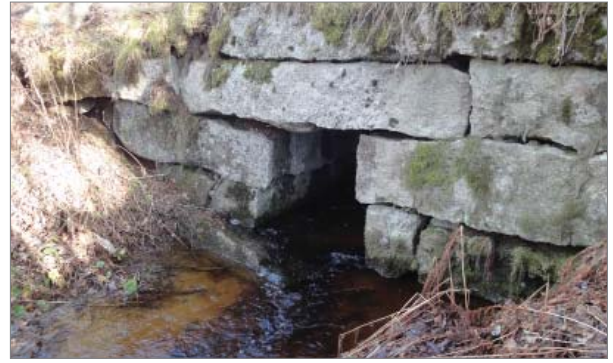
Nykyisen maantien 69 eteläpuolella ovat Piiparinkalliot. Siellä on ollut aikoinaan kivilouhos, nykyisin kivimurkskaamo, josta ajetaan jatkuvasti kiviainesta rakennuspohjaksi. Kivirumpu kestää hyvin raskaat kuormat. Rummun puusarjina näyttää veden läpi hyväkuntoiselta. Runmusta on irronnut reunakiviä, joista yksi on Telkkäpuron pohjassa. Kolme on siirretty muualle, mutta niiden palautus on vireillä. Kuva Martti Piltz
