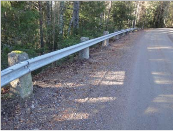
Työ on tehty huolellisesti. Tiepalle, ”jätkänpolku”, on poistettu kaiteen kohdalta. Kuva Martti Piltz
