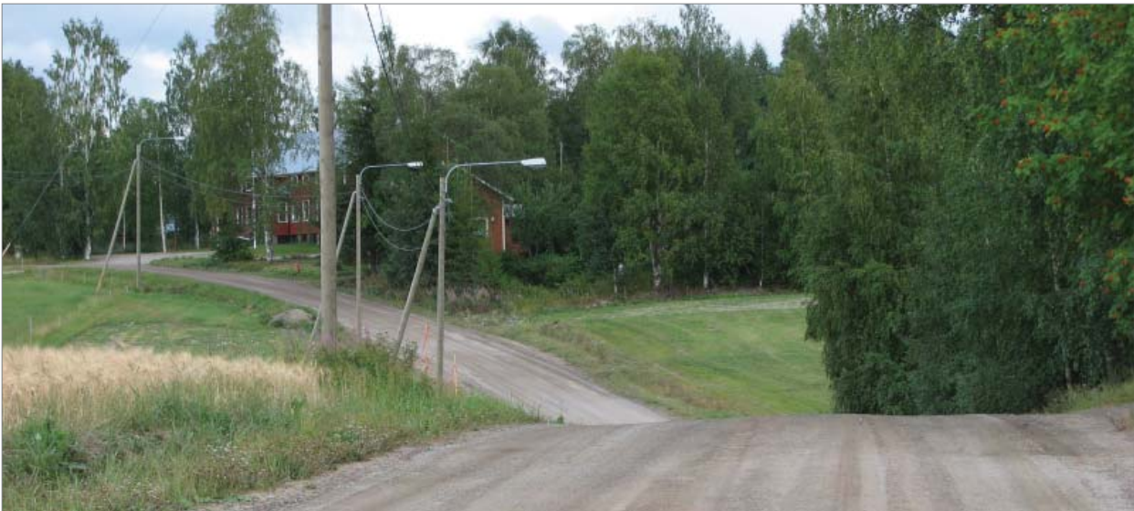
Tie on säilynyt hyväkuntoisena. Valaisimet ovat perinteisiä puupylväeseen sijoitettuja maantievalaisimia. Taustalla seuratalo. Kuva Kirsi Liimatainen
