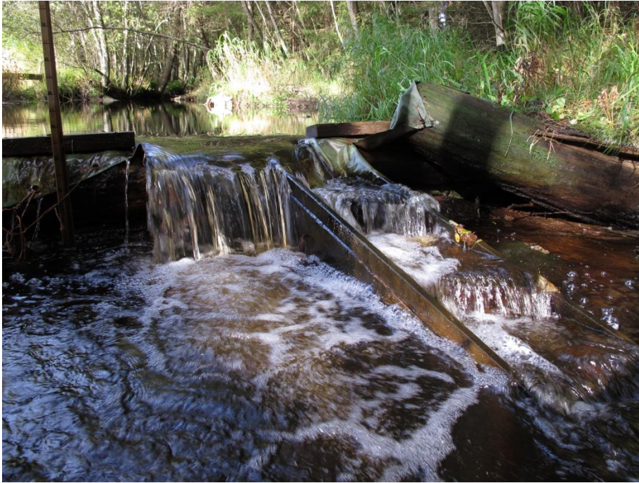
Kohde 3 ennen kunnostusta (kuva: Mika Sivil).
