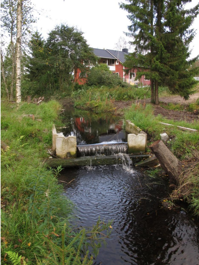
Kohde 2 ennen kunnostusta (kuva: Mika Sivil).
