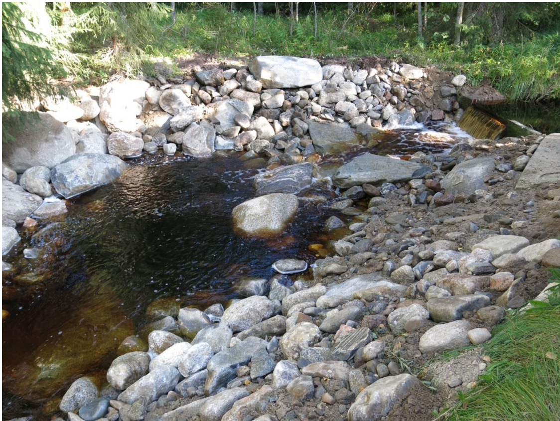
Kohteen 1 yläosa kunnostuksen jälkeen (kuva: Mika Sivil).
