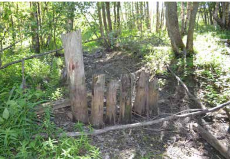
Vattenståndet i Mustfinnträsket har tidigare reglerats med en plankdam i utloppsdiket, men idag är dammen i mycket dåligt skick och fyller inte längre sitt syfte. Foto: Pasi Salmi
