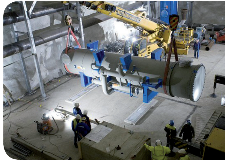
Kakolan lämpöpumppulaitoksen asennus (Oy Turku Energia Ab, Esko Keski-Oja)
