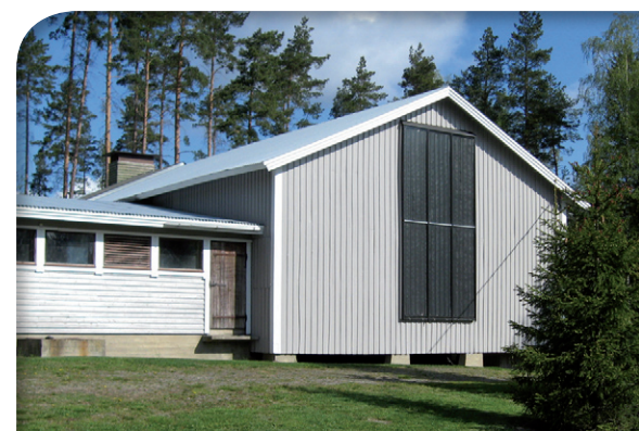
Aurinkokeräinten seinäintegrointi (Aurinkotori, Jarmo Kotiniemi)
