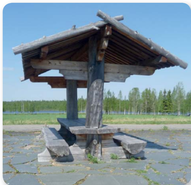
Kuva 7. Esimerkki luonnonmateriaalien käytöstä levähdysalueelta, päällysteenä liuskekivi ja katos kelopuuta. Kohde Pyhä-Luosto-matkailualueelta. Kuva Laura Soosalu.
