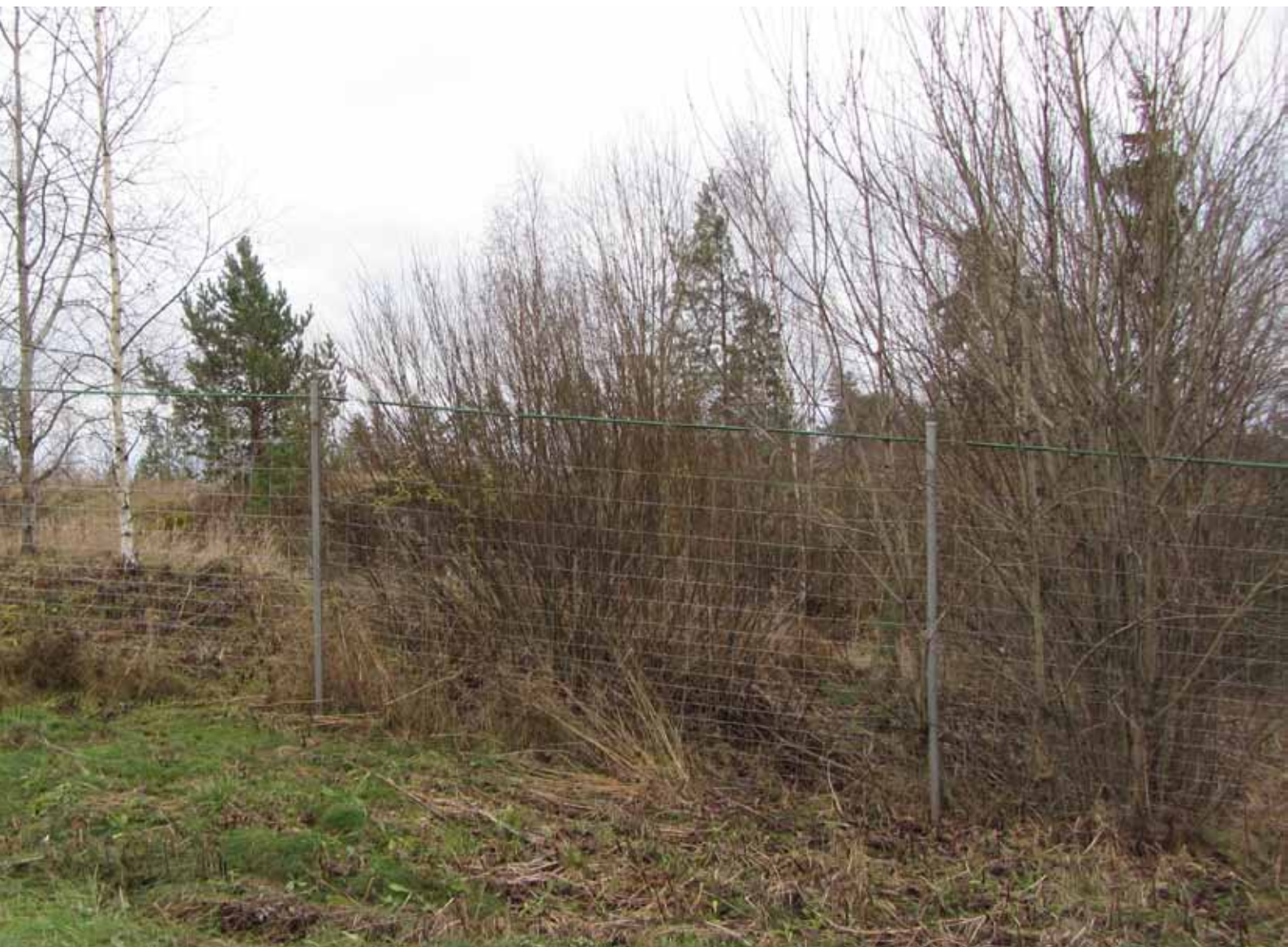
Kuva 28. Vesakkoa tulisi raivata myös riista-aidan toisella puolella.
