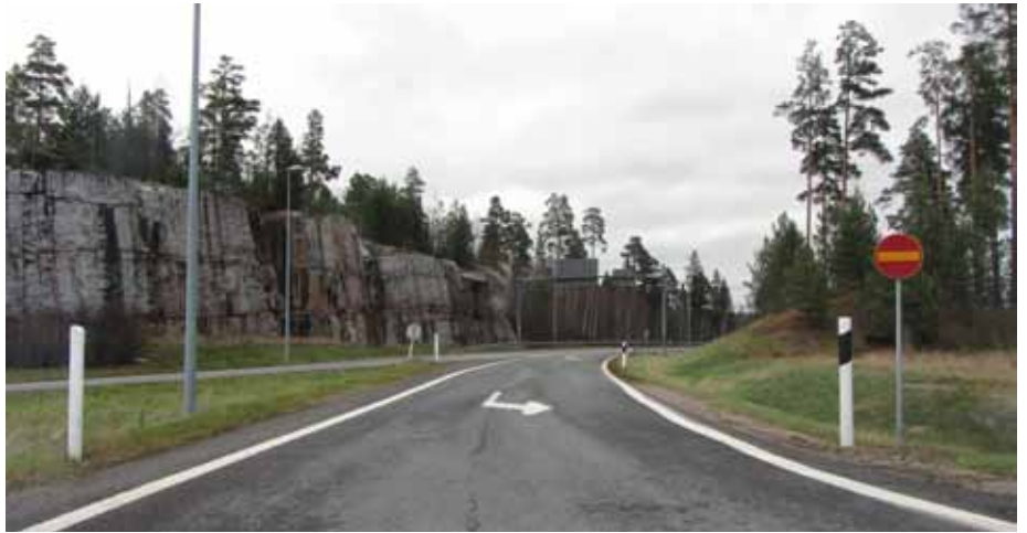
Kuva 29. Kielletyn ajosuunnan vasemman puoleinen merkki ja toistomerkit puuttuvat.
