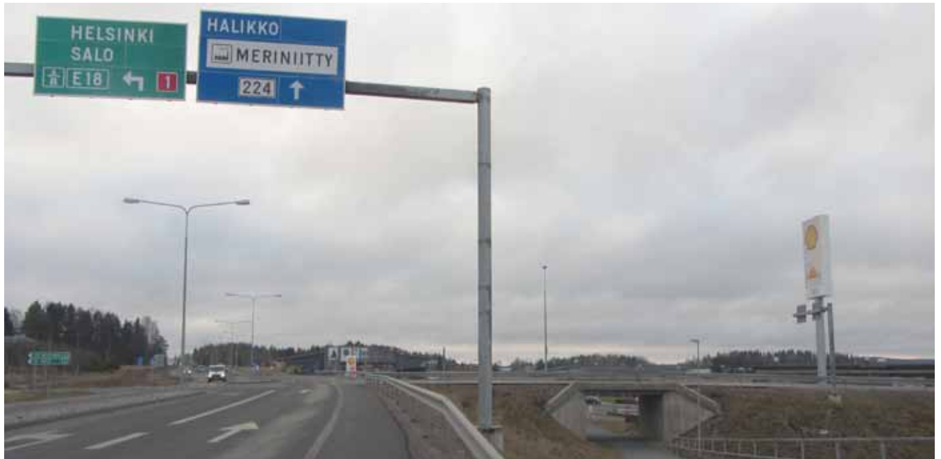
Kuva 30. Huono optinen ohjaus. Shell -merkki voi houkuttaa kääntymään oikealle vastaantulevalle rampille. "Oikealle kääntyminen kielletty"-liikennemerkki parantaisi tilannetta.
