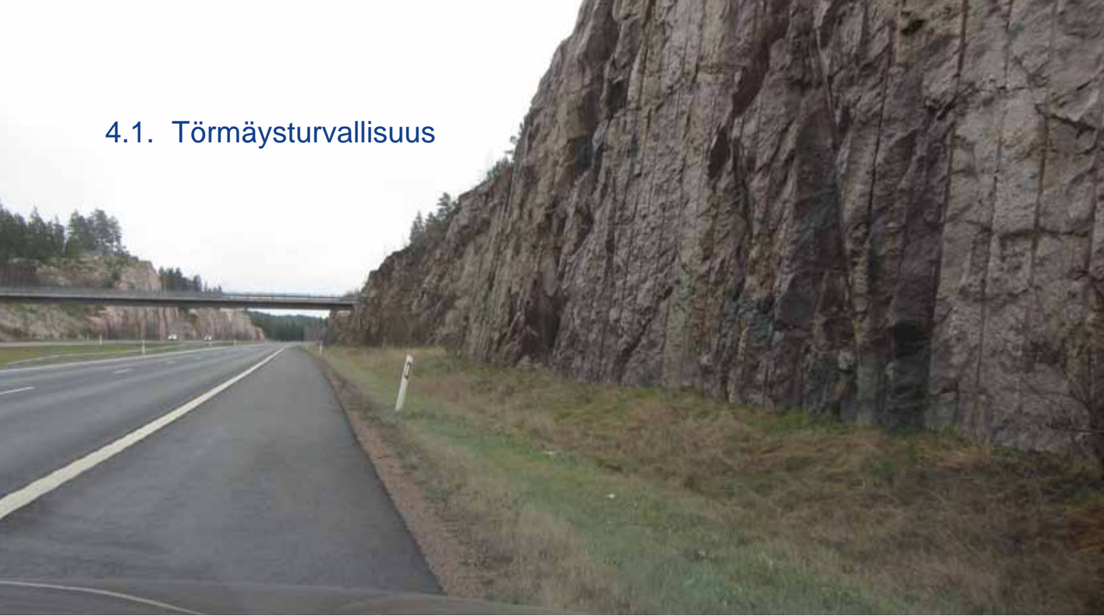
Kuva 13. Vanhemmilla tieosuuksilla kallioleikkauksen eteen tehty ulkoluiska on liian matala estämään auton törmäämisen kallioon.
