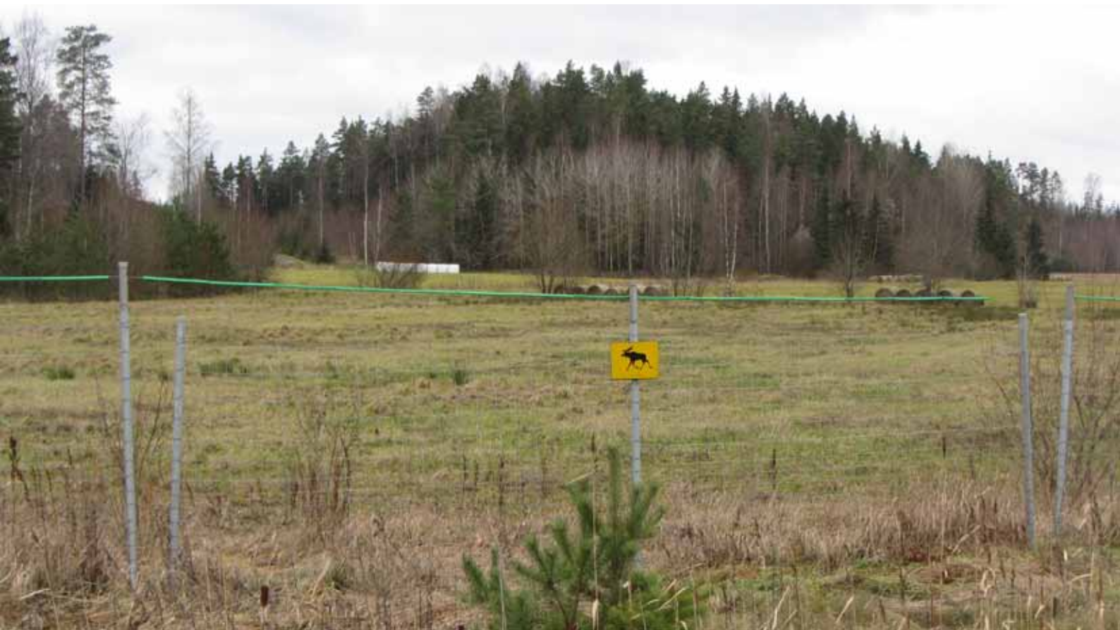
Kuva 26. Riista-aitojen porttien kohdilla on aukkoja, joista pienet peuraeläimet pääsevät teialueelle.
