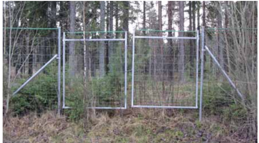
Kuva 26. Riista-aitojen porttien kohdilla on aukkoja, joista pienet peuraeläimet pääsevät teialueelle.
