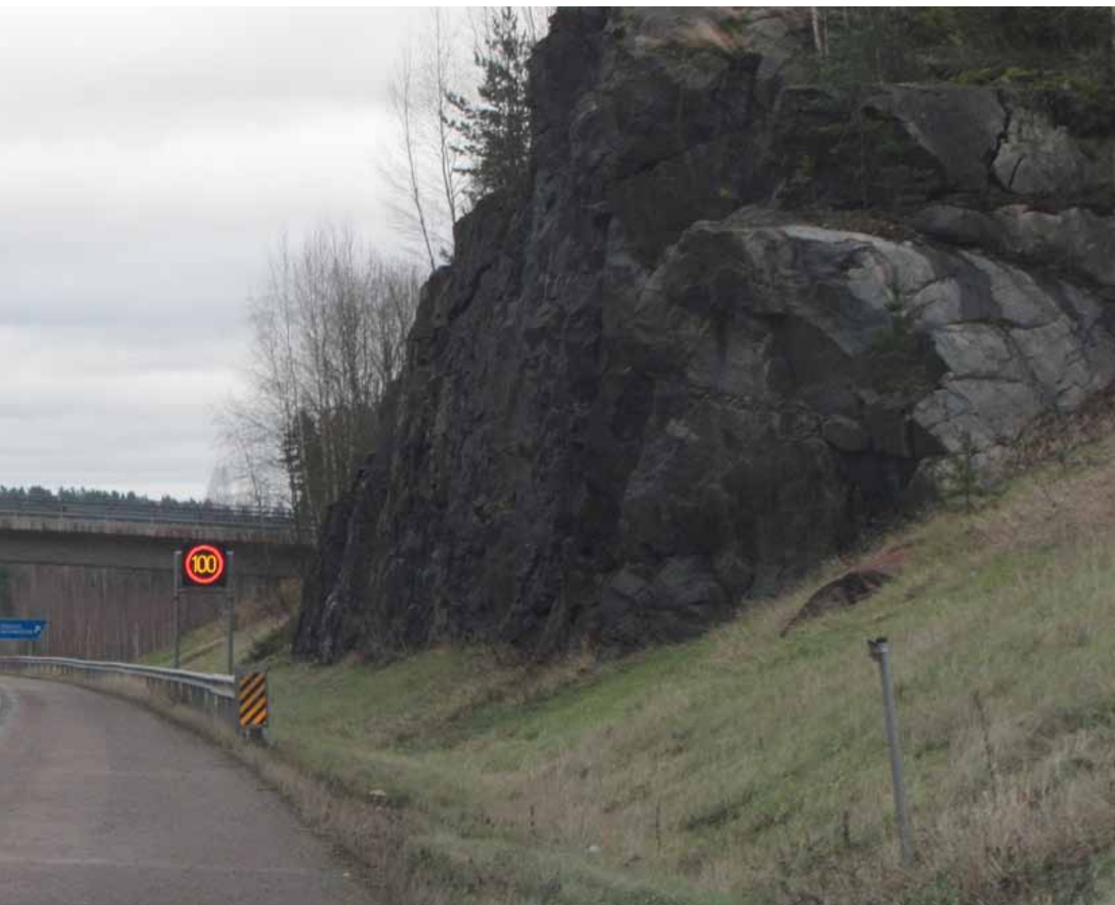
Kuva 16. Puut ja vesakot heikentävät suistumisturvallisuutta.
