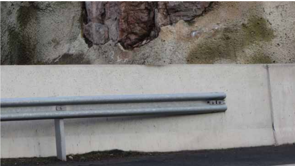
Kuva 23. Kaide on kiinnitetty ohjeiden mukaisesti kahdella pultilla jäykkään rakenteeseen ankkuroinnin varmistamiseksi sekä tuotu muutamia metrejä jäykän rakenteen päälle. (Lähde: Kaiteet ja suistumisonnettomuuksien ehkäisy. TIEH 2100014-02. Tiehallinto 2002)
