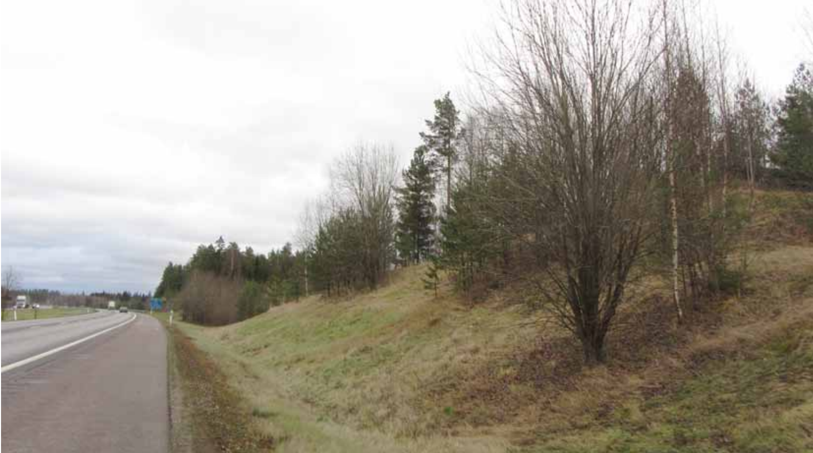
Kuva 16. Puut ja vesakot heikentävät suistumisturvallisuutta.
