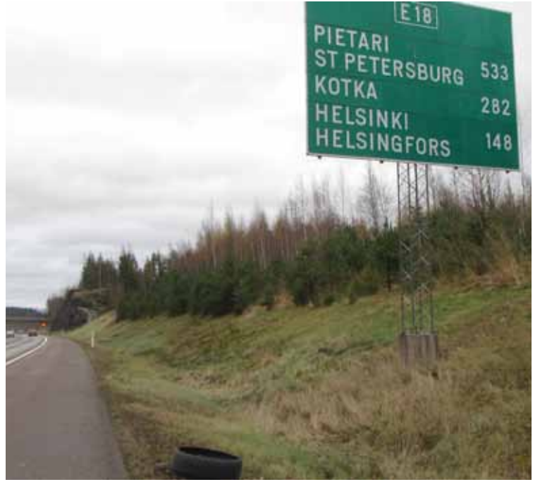
Kuva 20. Korkea betonijalusta ulkoiluissa heikentää suistumisturvallisuutta.
