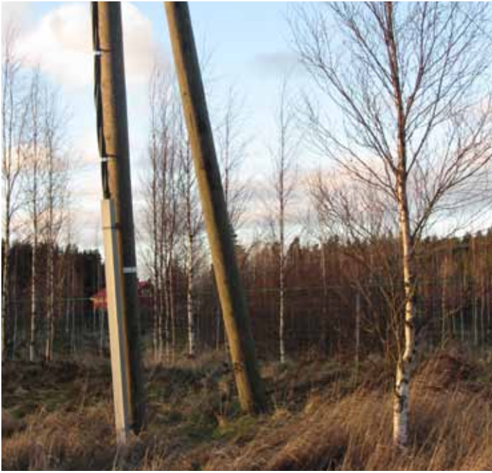
Kuva 19. Pylväät ja puut ulkoiluissa heikentävät suistumisturvallisuutta.
