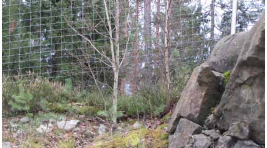
Kuva 24. Riista-aitojen alla esiintyy paikoittain suuria aukkoja, joista pienet peuraeläimet pääsevät teialueelle.
