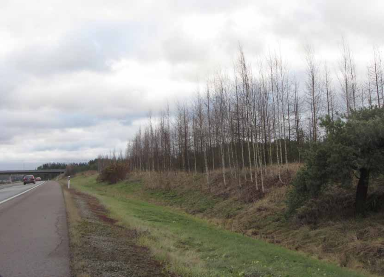
Kuva 17. Puut ulkoluiskassa heikentävät suistumisturvallisuutta.
