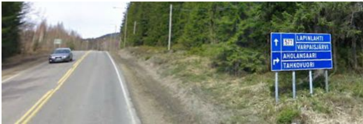
Kuva 3-2. Suunnistustaulu maantiellä 577 ennen Tahkolle johtavan maantien 5775 liittymää. Sivusuunnan viitoituskohteeksi esitetään pelkästään ”Tahko”.
