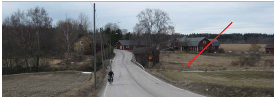
Kuva 12. Uusi kevyen liikenteen väylä ylittää Kauhalanjoen rummulla.
