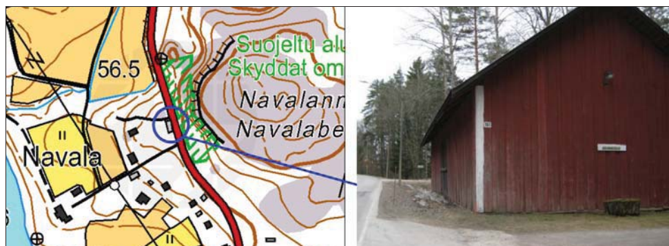
Kuva 17. Kiinteistön 257-449-2-409 mahdollisesti lunastettava rakennus.
