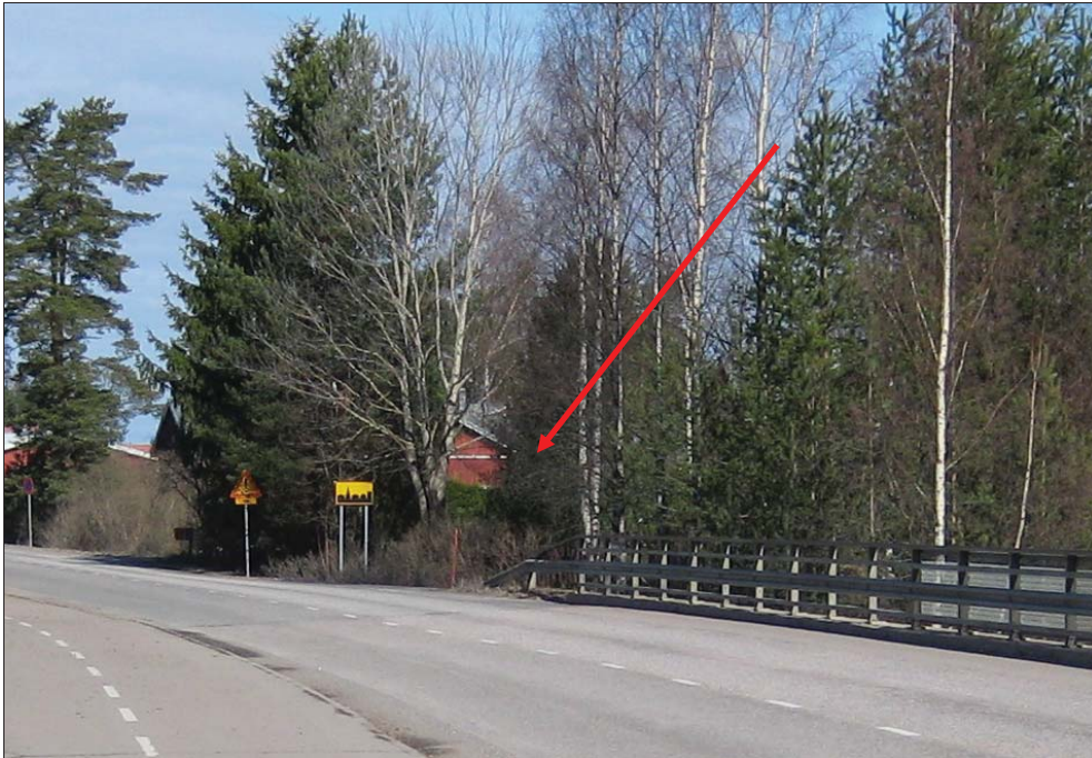
Kuva 18. Kevyen liikenteen lähtö Nummensyrjän risteysilta länsipuolella. Näkemien kannalta kevyen liikenteen lähtö on hankala.
