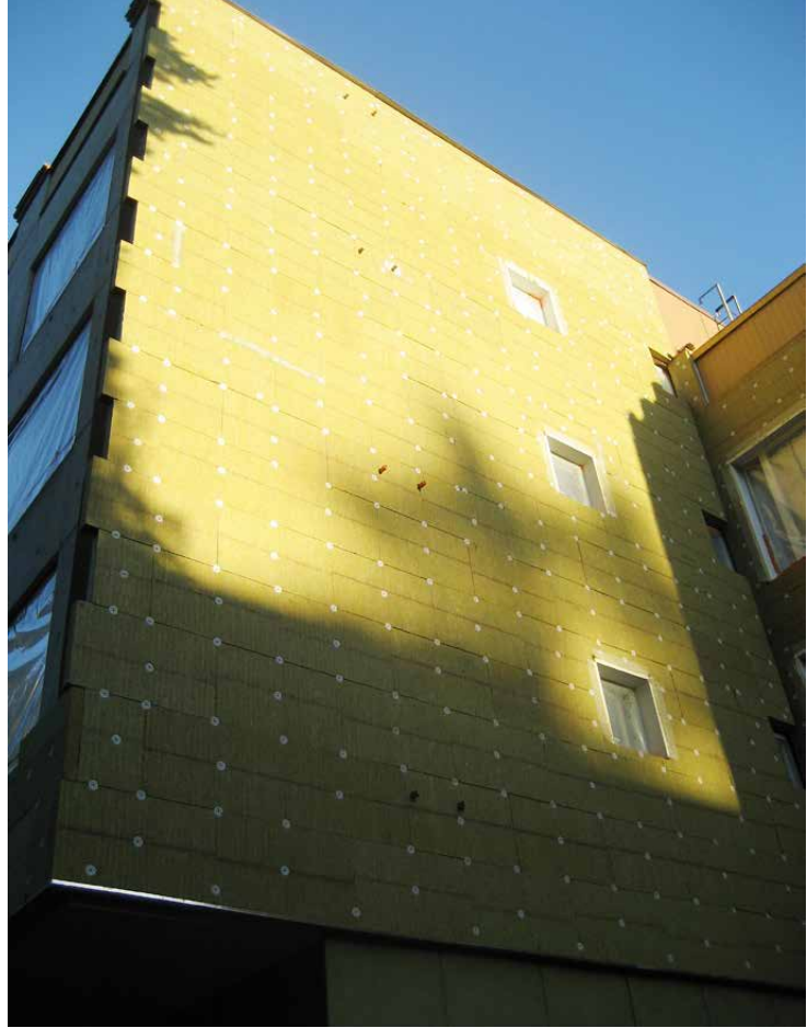
Betonielementtitalon lämpörappaus lisää asumismukavuutta ja vähentää lämmitystarvetta. Kuva: Sami K. Mörsky
