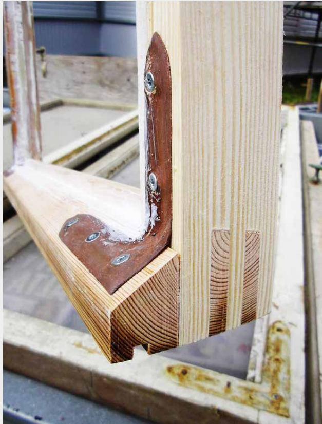
Korjausrakentaminen edistää työllisyyttä ja säästää luonnonvaroja. Kuva: Maria Luostarinen
