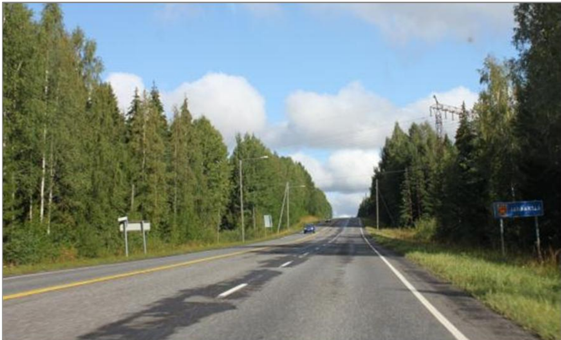
Kuva 30. Ohituskaista maantiellä 130 tieosalla 11.
