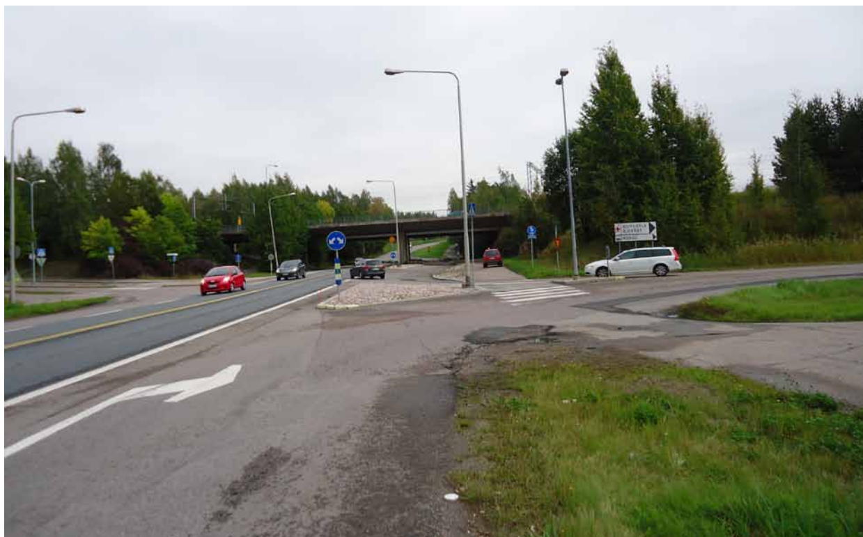
Kuva 45. Maastokohde Vantaalla. Suojatien oikeanpuoleisen osan pituus on 8 metriä ja kaistan leveys kuvitteelliseen reunaviivaan noin 6 metriä, päällysteen reunaan enemmän. Ajokaistan reunaviiva puuttuu ja suojatiemaalaukset näyttävät alkavan vasta suojatien puolesta välistä.
