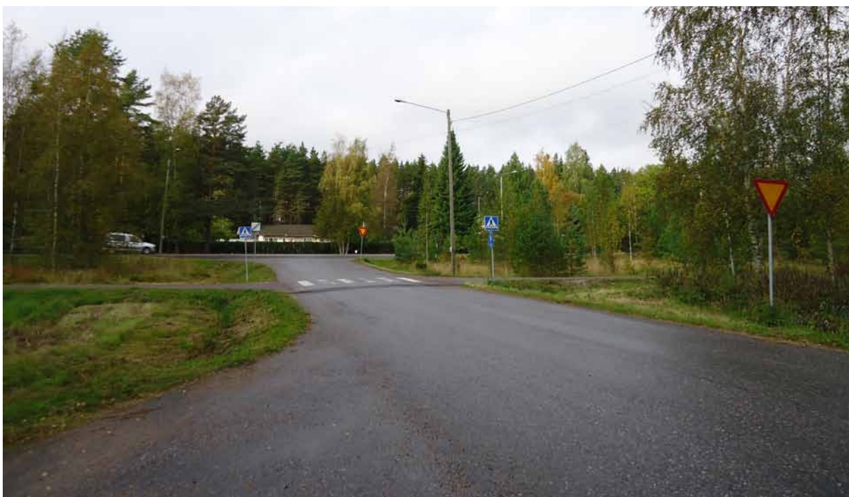
Kuva 44. Maastokohde Orimattilassa. Liittymän ja suojatien välinen etäisyys on 20 metriä, ja kärkikolmio ennen suojatietä on vain liittymän suuntaan ajavilla.
