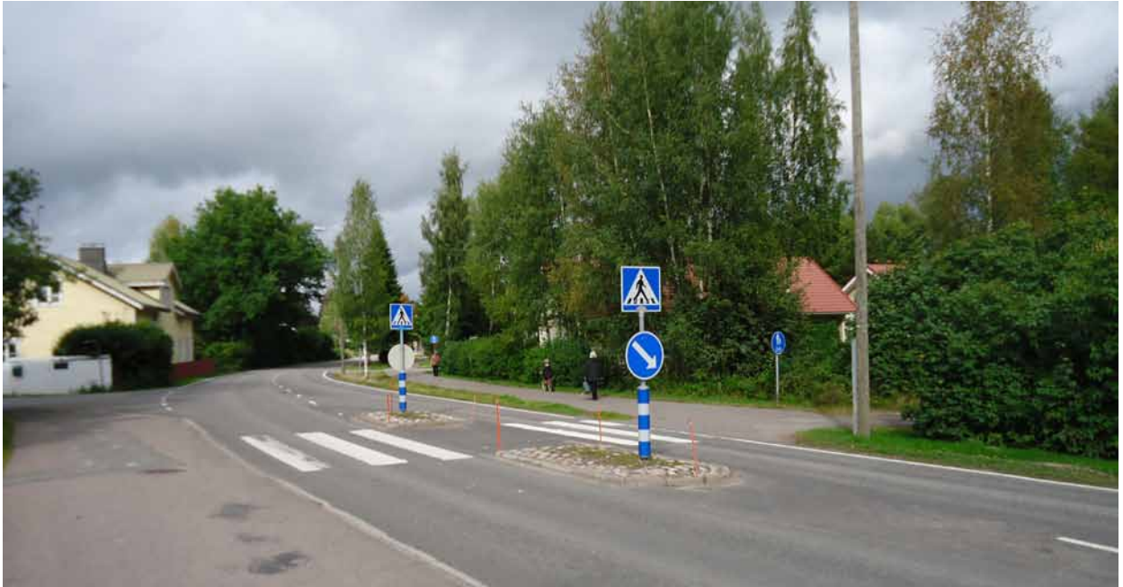
Kuva 31. Maastokohde Sammatissa. Suojatiemerkit on sijoitettu keskisaarekkeelle, ja pylväissä on tehostemerkinnot. Kohde on esimerkki hyvin erottuvasta suojatiestä.
