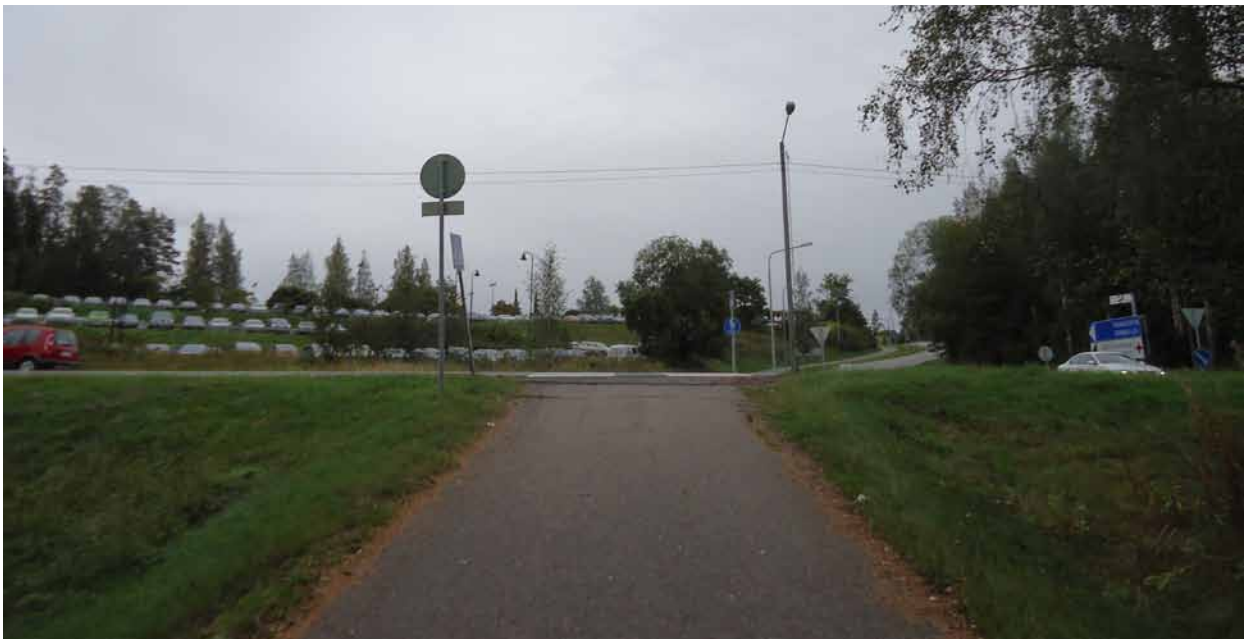
Kuva 32. Maastokohde Espoossa Turuntiellä (Mt 110) kuvattuna kevyen liikenteen väylältä. Kevyen liikenteen väylältä on suojatielle yli 10 % nousu, mikä haittaa näkyvyyttä sekä ajoradalle että ajoradalta kevyen liikenteen väylälle.
