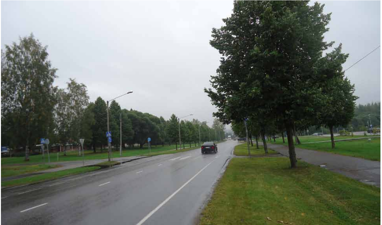
Kuva 41. Maastokohde Janakkalassa. Suojatiemerkinnot erottuvat huonosti märästä asfaltista ja tien oikealla puolella oleva suoja- tiemerkki on puun lehdistön takana.
