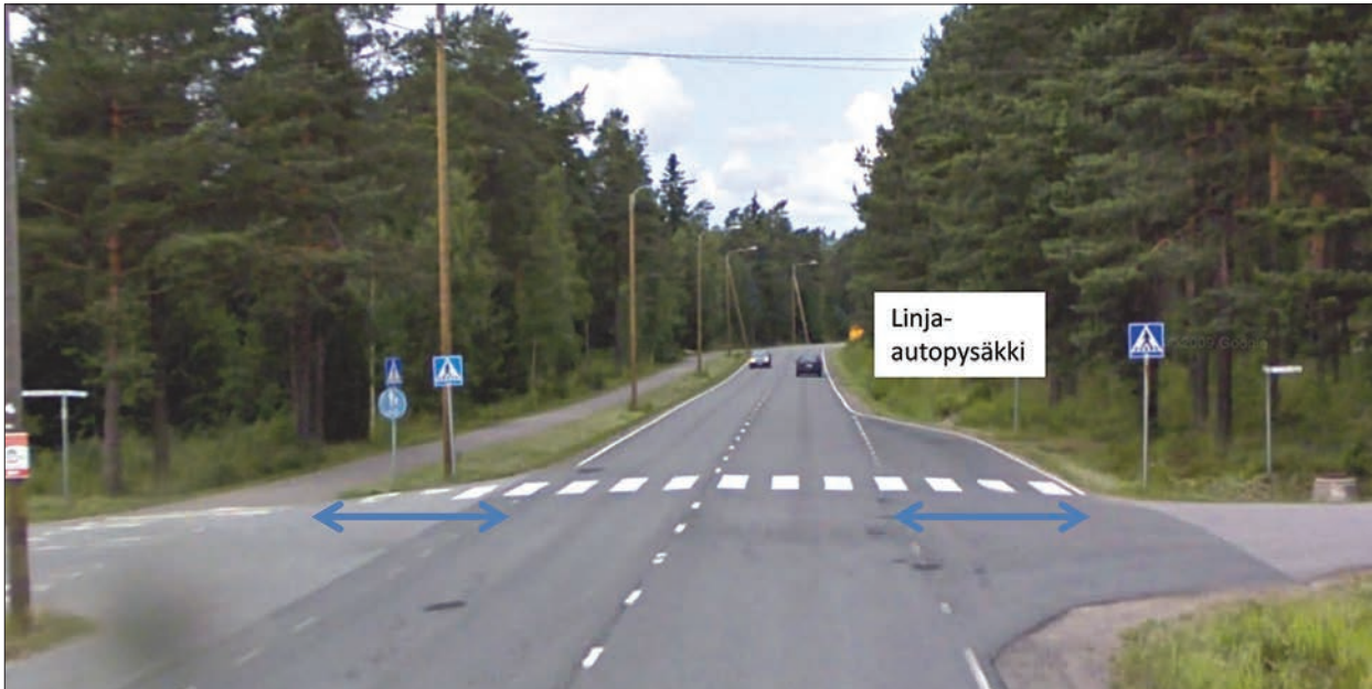
Kuva 39 Esimerkkikuva linja-autopysäkin yhteyteen toteutettu suojatie.
