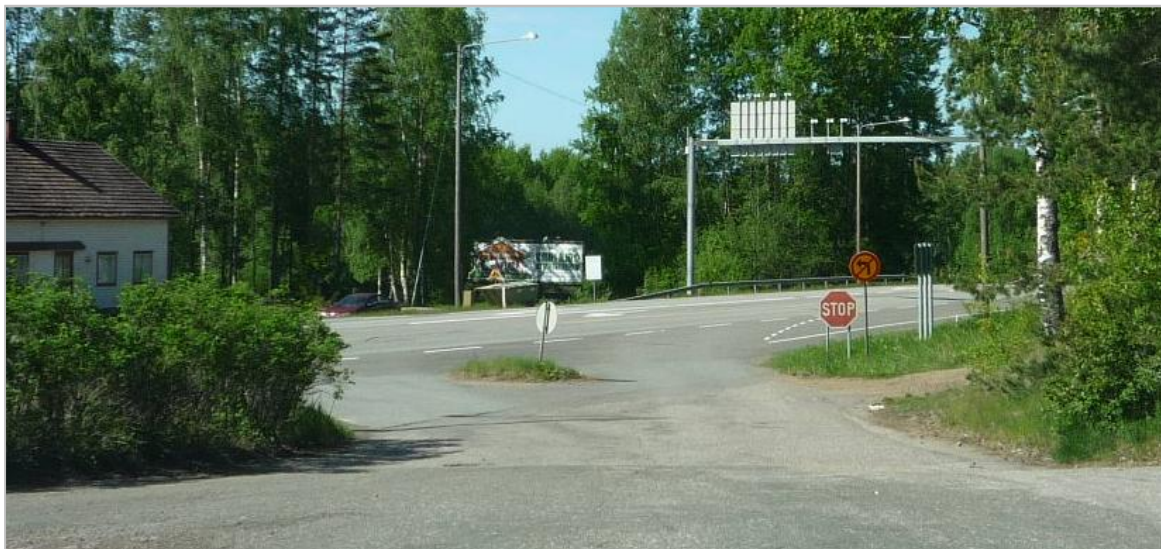
Kuva 25. Luumäen motellin itäinen STOP-merkin varusteltu liittymä (toimenpiteenä pysähtymisviivan maalaaminen, pitkällä tähtäimellä tavoitteena liittymän poistaminen).
