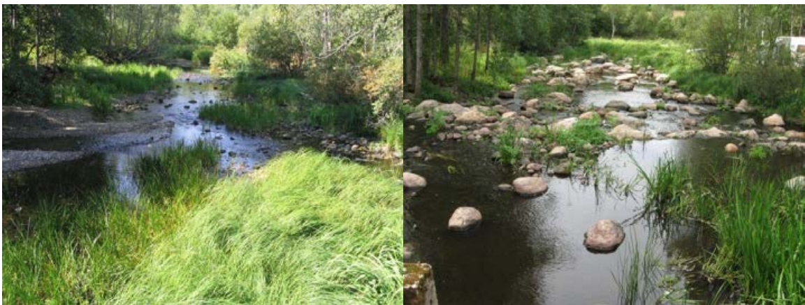
Kuva 15. Padon alapuolinen jokiuoma sillalta alavirtaan tarkasteltuna. Vasemmalla jokiuoma vuotta ennen kunnostusta vuonna 2006. Oikealla sama alue soraistettuna ja kivettynä kunnostuksen jälkeen vuonna 2010. Kuvassa näkyvä alue noin 50 m sillasta alavirtaan ja oikean puoleisessa kuvassa etäällä näkyvä kiveys kuuluu alempaan kunnostettuun sivu-uomaan. Kuvat: Esa Lehtinen.
