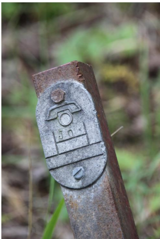
Kuva 13. Telekaapeliinjan merkki maantien 313 varressa.
