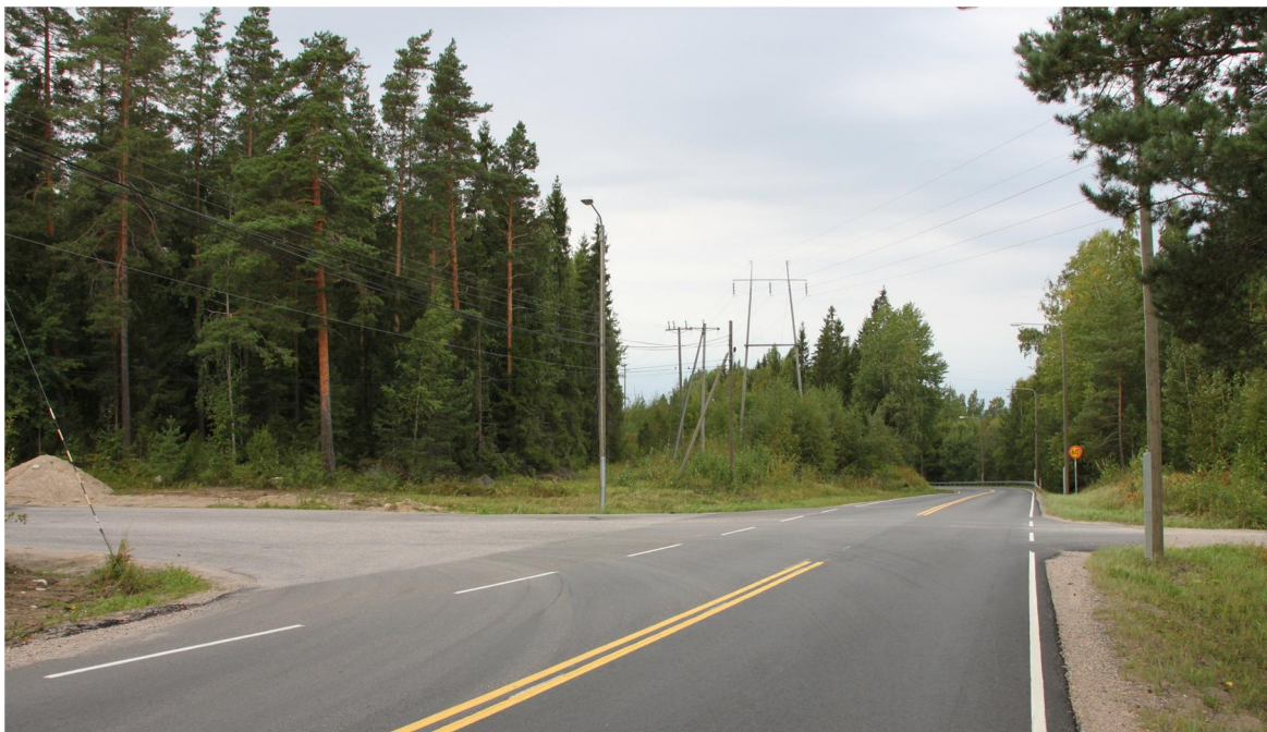
Kuva 16. Maantien 313 ja Vehkoontien liittymä idästä suunnittelualueelle päin katsottuna.
