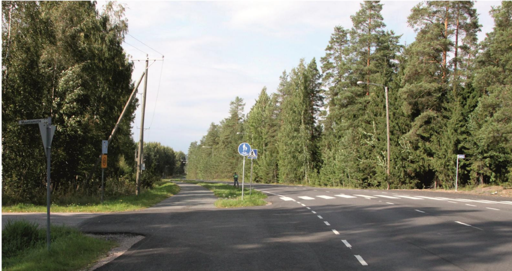
Kuva 8. Kevyen liikenteen väylä Muuntamotien ja Mustaniementien liittymästä Vääksyn keskustaan päin.
