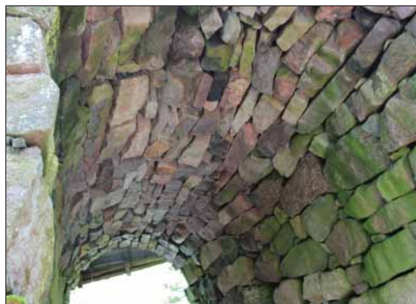
Sågbron holvi on melko karkeasti rakennettu. Kivien koko ja muoto vaihtelevat selvästi. Qvarnbron ja Sågbron rakennustapa näyttävät samalta, kun taas Qvarnbron sillan ja myllyn seinän yhdistävä holvi on kehittyneempää rakennetta. Kuva Petra Kotro.
