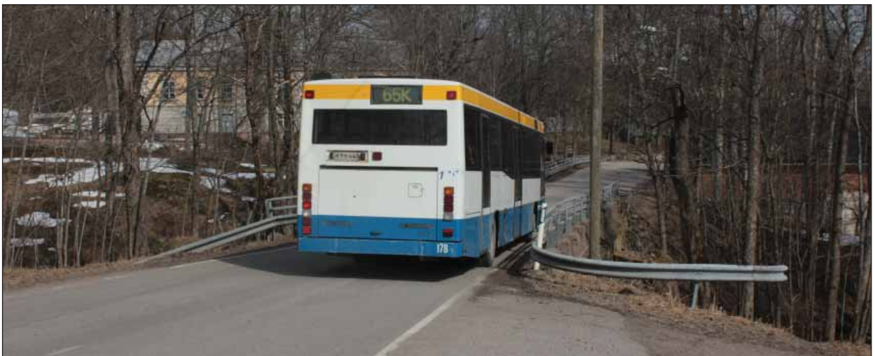
Tien ja siltojen mittasuhteisiin linja-auto on suuri. Sillat on rakennettu noin tonnin kuormalle eli hevoselle rattaineen. Siltojen rakenne on hyvin vankka, koska ne ovat kestäneet liikenteen rasitukset lähes 250 vuoden ajan. Nyt painorajoitus on 16 tonnia. Kuva Petra Kotro.
