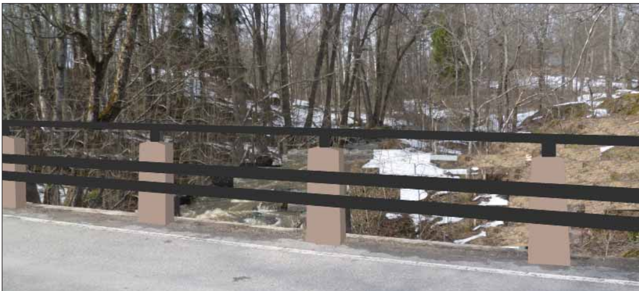
Ehdotus kaiteen kunnostamiseksi, idealuonnos. Nykyiset kivipaadet korotetaan, ajojohde korvataan mustalla putkikaiteella. Kaideratkaisun tulee ulkonäön kohentamisen lisäksi täyttää turvallisuusmääräykset. Kuva Laura Soosalu.
