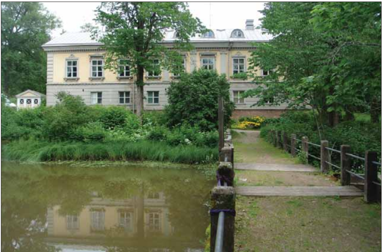
Kartanon ja sen tuotantopihoilla kulkee melko tiheä ja laaja pienten kävely- tai huoltoteiden verkko, joilta siltojen tarkastelu on mahdollista ilman mitään erikoisjärjestelyjä. Eräs mielenkiintoisista kohteista on myllyn pato ja patoallas. Kuva Martti Piltz.
