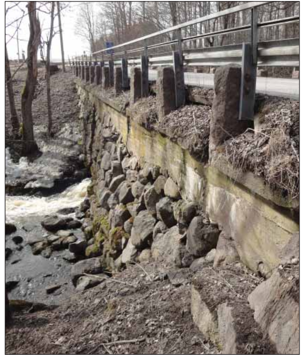
Sågbron rakenteita. Kuva Laura Soosalu.
