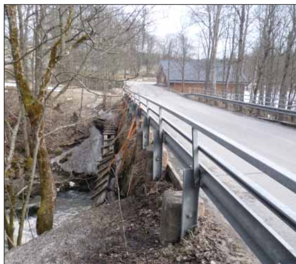
Vanhoja sillan kaiteita on jatkettu korottamalla niitä teräskai-teella. Kaapelikotelot roikkuvat liinojen varassa. Tien taseus on noussut jopa 70 cm ja vanhat kaiteet ovat jääneet liian mataliksi. Kokonaisuus ei ole kulttuurihistoriallisesti merkittävän miljööän arvon mukainen. Kuva Laura Soosalu.
