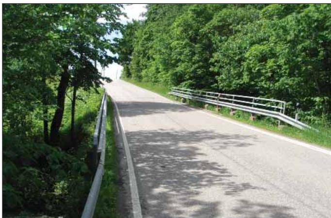
Espoonkartanon Sågbro maastoutuu kesäaikaan lähes näkymättömiin jokilaakson rehevään kasvillisuuteen. Silta on vaikeasti tulkittavissa erääksi Suomen arvokkaimmista tieliikennehistoriallisiksi ja laajemmin kulttuurihistoriallisiksi kohteeksi. Sillan ja tien yleisilme eivät helpota havaittavuutta tai tulkittavuutta. Kuva Martti Piltz.
