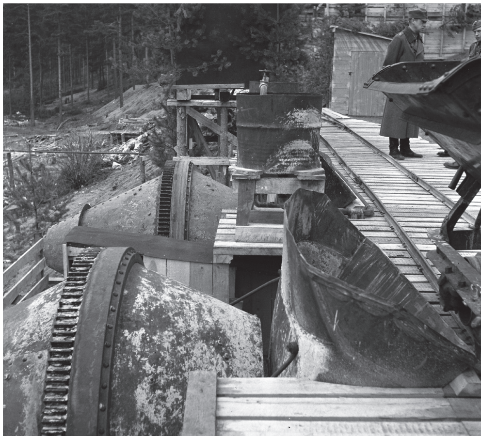
Betoninsekoittajia VT-linjan rakennustyömaalla toukokuussa 1944.
