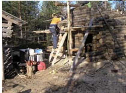
Kuva 14. Käymälän rakentamista Kiimäselän taukopaikalla. Kuva Panu Leinonen.
