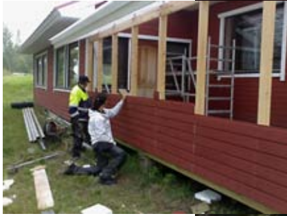
Kuva 25. Välinevaraston rakentamista. Kuva Ossi Kukkonen.
