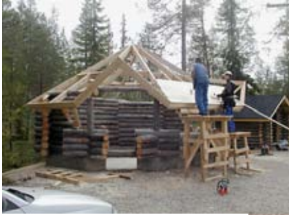
Kuva 10. Kallunkijärven uimarannan kodan rakentamista. Kuva Vesa Lukkarila.
