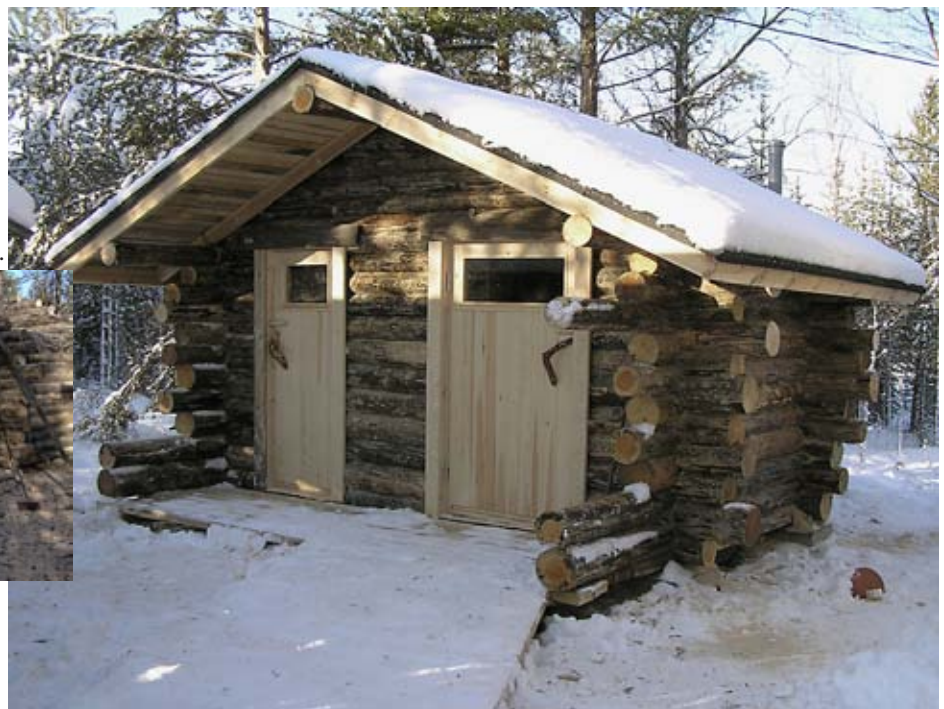
Kuva 15. Käymälä valmiina. Kuva Panu Leinonen.
