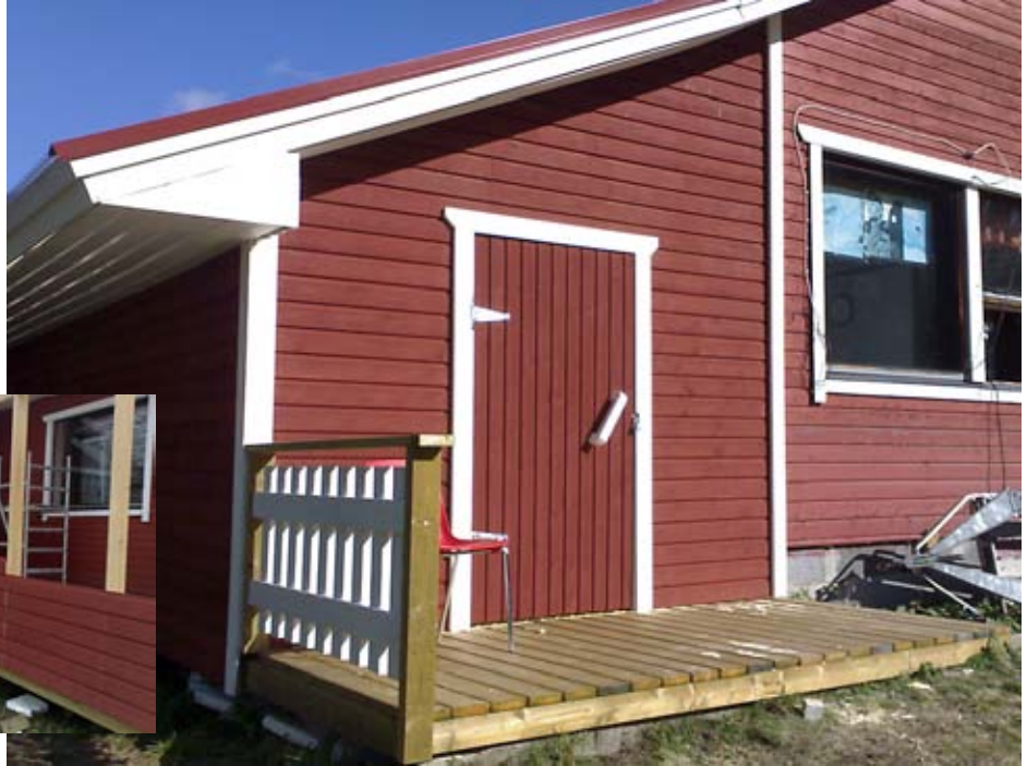
Kuva 26. Välinevarasto valmiina. Kuva Ossi Kukkonen.
