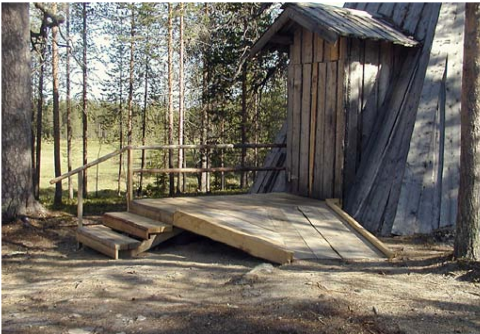
Kuva 34. Kesällä 2009 rakennettiin Sallan Poropuistoon kodan sisäänkäynnin yhteyteen invaluiska. Kuva Vesa Lukkarila.
