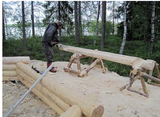
Kuva 22. Hirsien salvontaa. Kuva Sirpa Lithovius.
