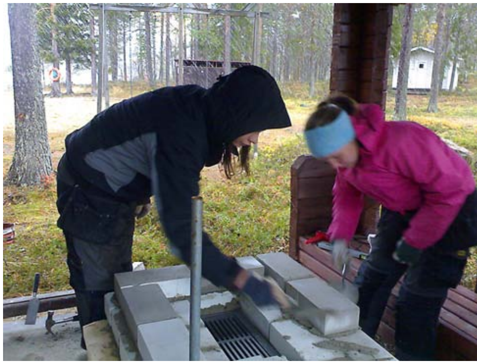
Kuva 29. Grillin muurausta. Kuva Ossi Kukkonen.
