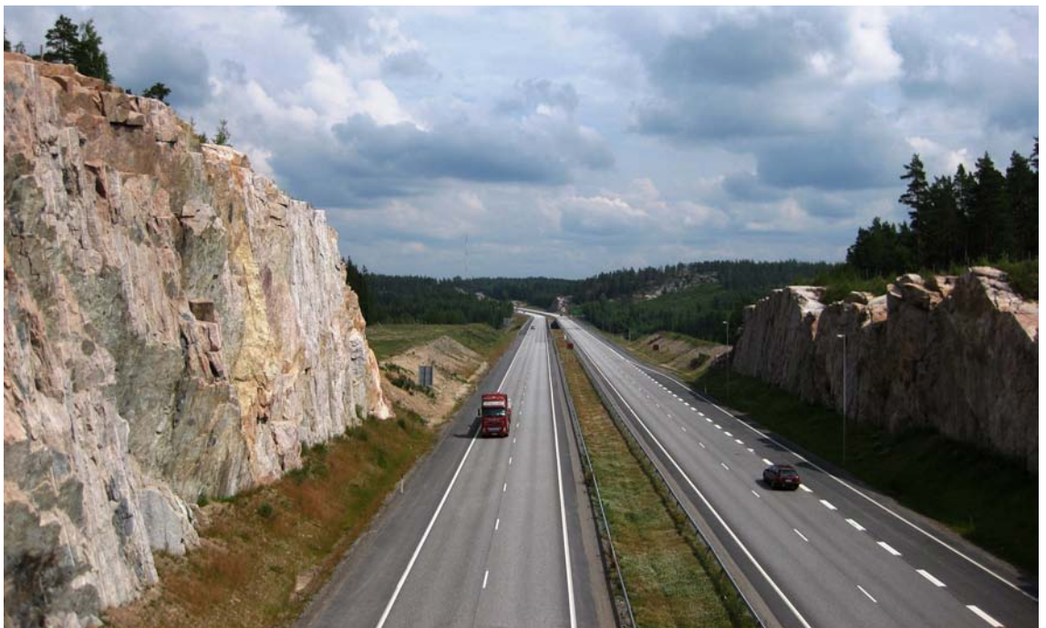
Kuva 32. Riihelän risteyssillan itäpuolella sijaitseva kallioleikkaus on enimmillään lähes 30 metriä syvä.
