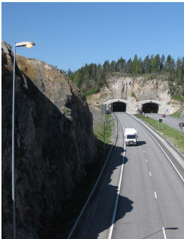
Kuva 2. Orosmäen tunnelin itäinen suuaukko
