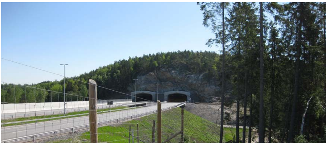
Kuva 28. Orosmäen tunnelin läntinen suuaukko.
