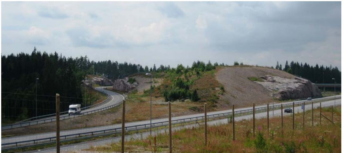
Kuva 17. Kruusilan liittymää Aron kiinteistön alueella.
