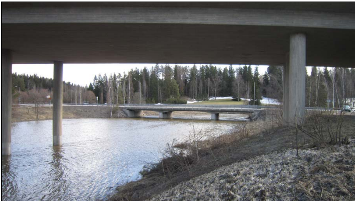
Kuva 16. Kevyen liikenteen väylä ylittäisi Mustijoen omalla sillalla nykyisten moottoritiesiltojen ja maantien 170 sillan väliltä.
