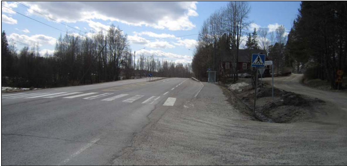
Kuva 12. Maantien 170 nykyinen ylitys suojatiellä Palokunnantien (mt 11750) liittymän itäpuolella ei ole nykyisten suunnitteluohjeiden mukainen.
