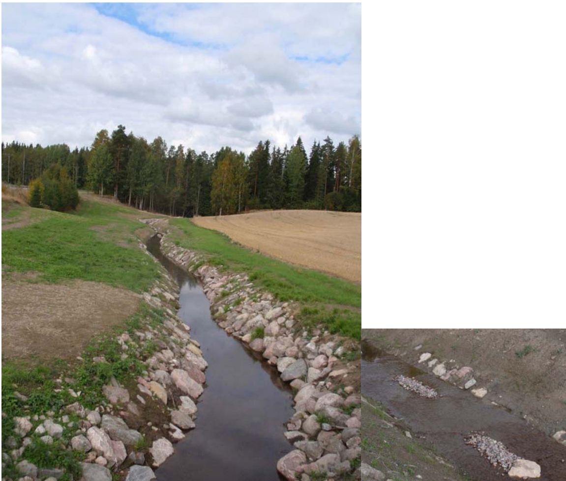
Kuvat 8. Joki kulkee Sarvikallion eteläpuolella kahden lohkon välissä. Joen uoma on kunnostettu kesällä 2010. Kuva 9. Joen pohjalle on lisätty soraa ja uomaan kiviä.
