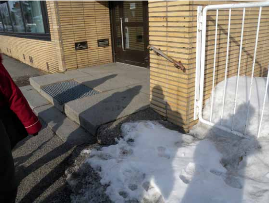
Kuva 2. Tilitoimiston luiska ei ole toimiva; se on liian kapea ja sitä ei ole puhdistettu lumesta.
