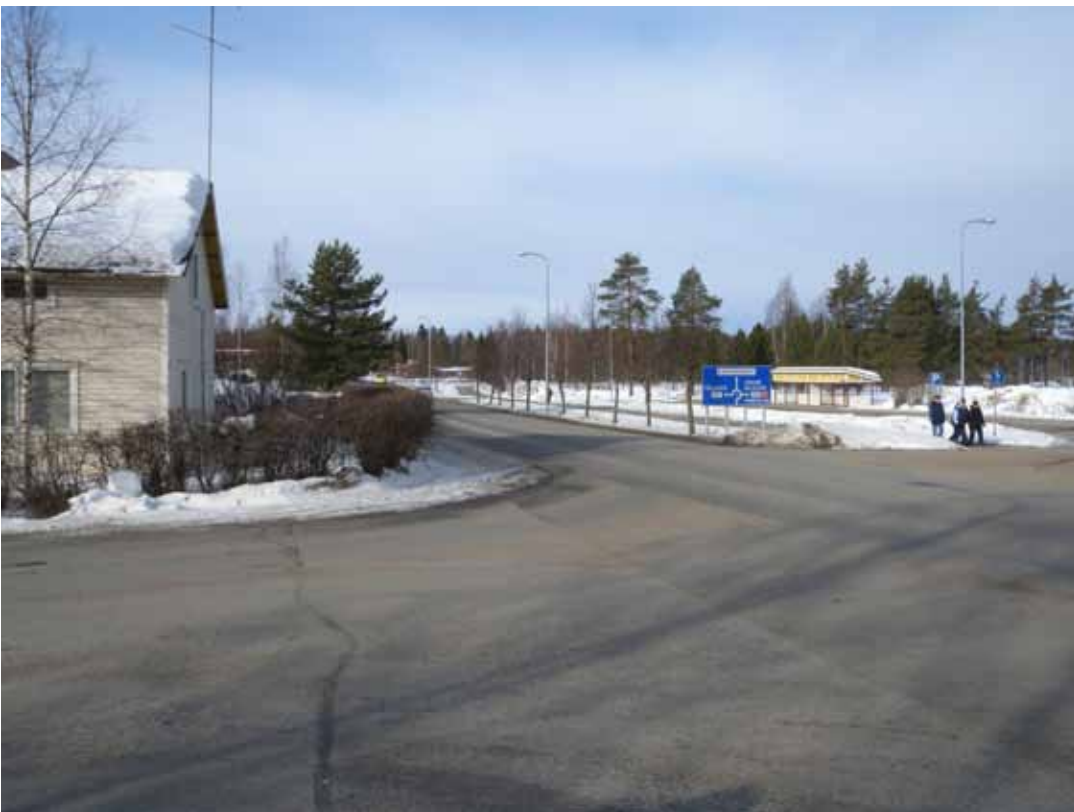
Kuva 3. Pensasaita aiheuttaa näkemäesteen Kukkomäentien ja Niemistenkadun liittymässä.
