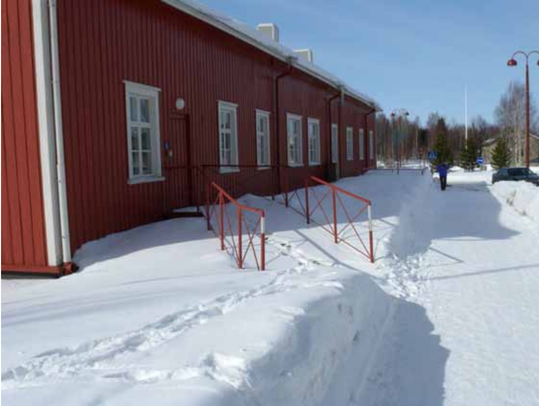
Kuva 5. Myös kunnanviraston luiska oli auraamatta. Muilta osin luiska on hyvin toimiva; se on riittävän loiva ja leveä.
