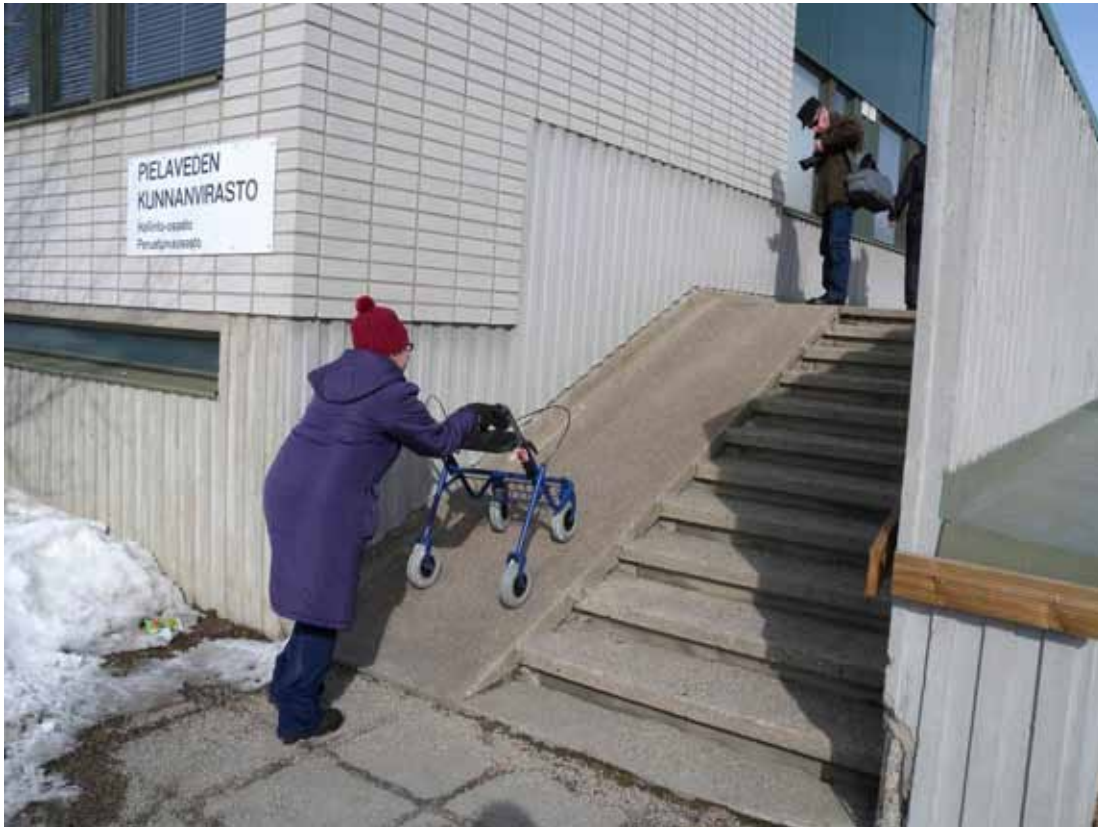
Kuva 3. Esimerkki käyttökeltvottomasta luiskasta.
