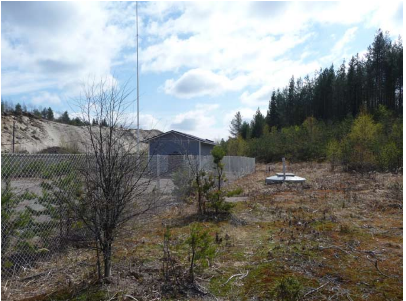
Vedenottamo toiminnassa olevassa sorakuopassa Karttulassa. Kohde nro 82270601.
