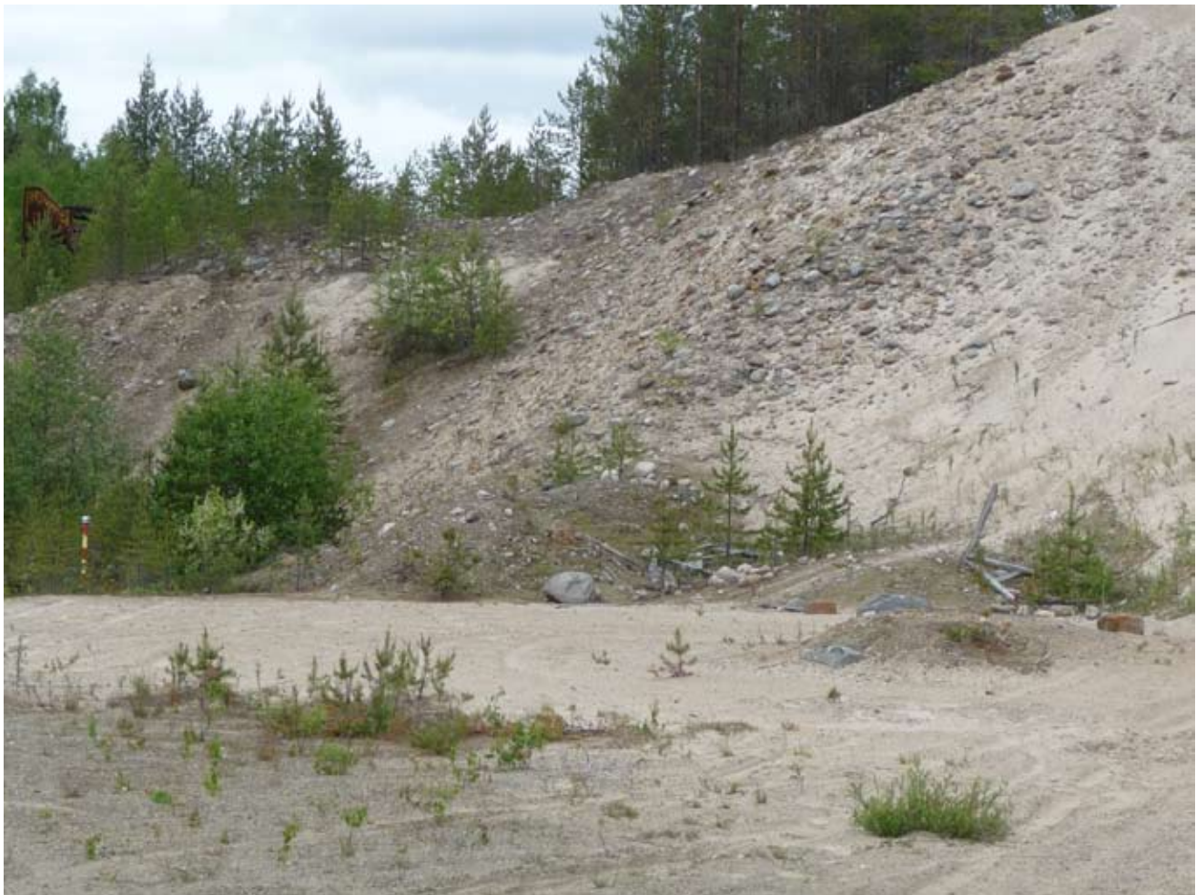
Kohde 87780117 sijaitsee Lintharjun pohjavesialueen kaakkoisosassa. Kuvassa näkyvästä pohjavesiputkesta mitattu etäisyys maanpinnasta pohjaveden pintaan on noin 0,5 metriä. Taustalla näkyy vanha välppä.
