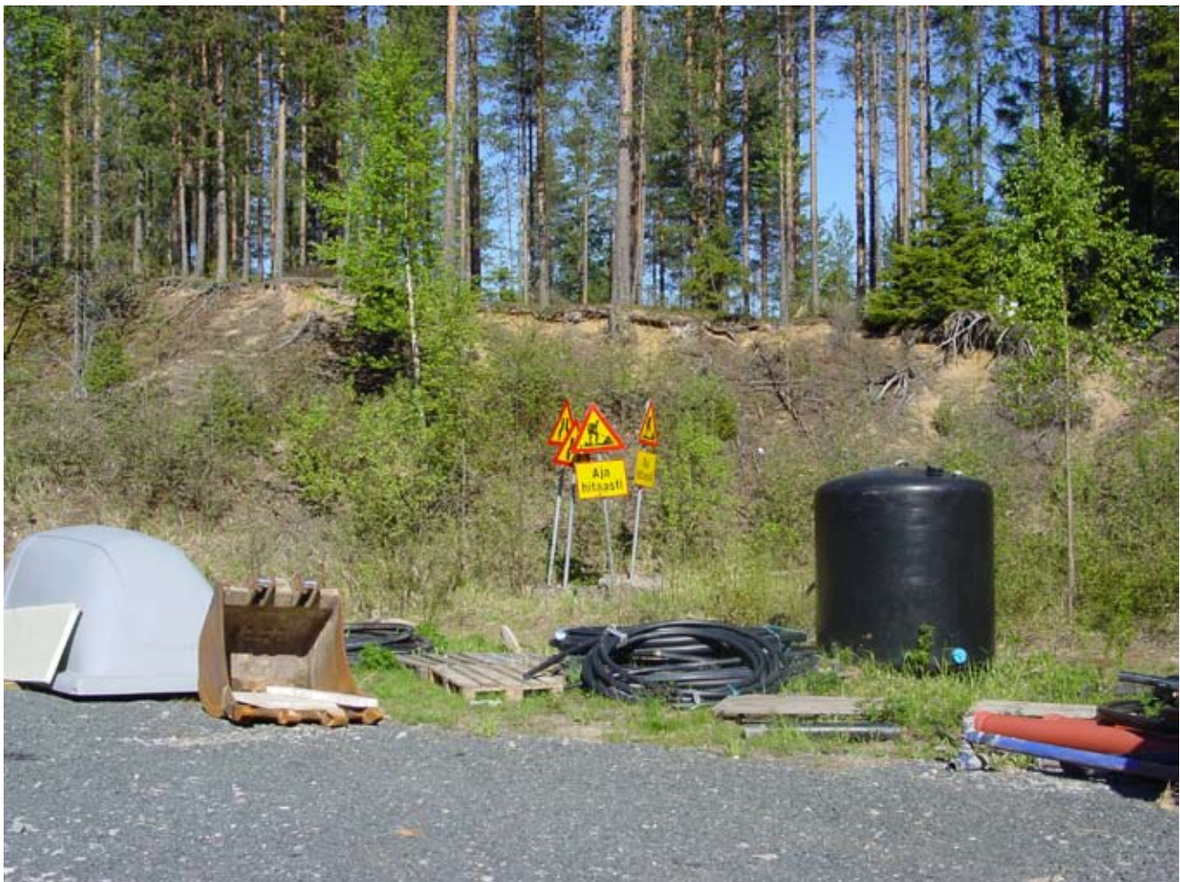
Kohde 87495108 sijaitsee Kärängänmäen pohjavesialueella lähellä vedenottamo. Kuopassa on paljon tavaraa.
