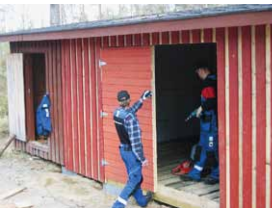
Puuvaraston ovea sovitetaan paikalleen.
