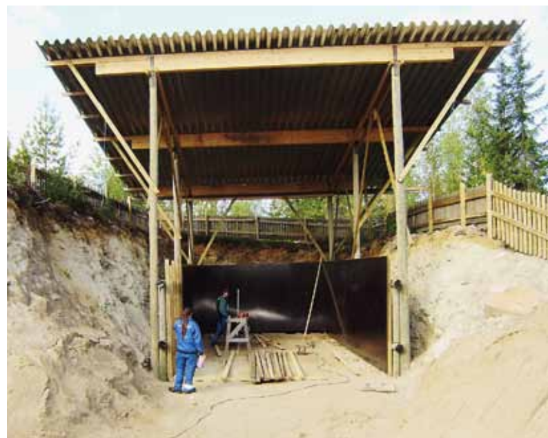
Hiekkavaraston maanpaineseinän viimeistelytyöt meneillään.
