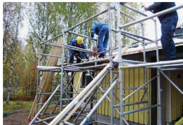
Kattojen kunnostaminen vaatii kunnan telinerakenteet työskentelyä varten.
