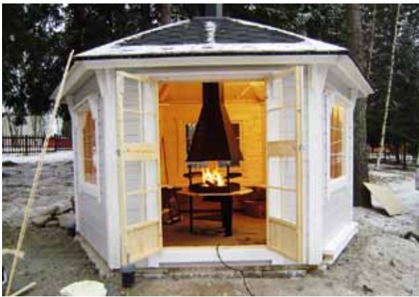
Uusi grillikatos valmiina.
