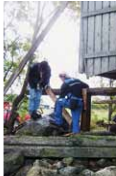
Tuulimyllyn kunnostustyöt Haalanmäellä aloitettiin. Mylly tuettiin kengitystä varten.
