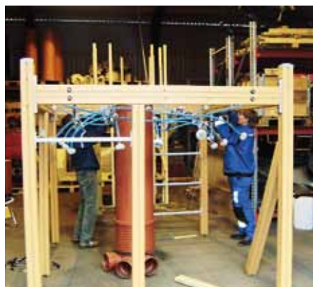
Leikkikenttävälineet koottiin valmistajien ohjeiden mukaan valmiiksi varikolla. Valmiit välineet pystytettiin leikkikentille.
