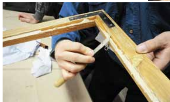
Koulutuksen aikana päästiin kokeilemaan mm. ikkunan kunnostamista.
