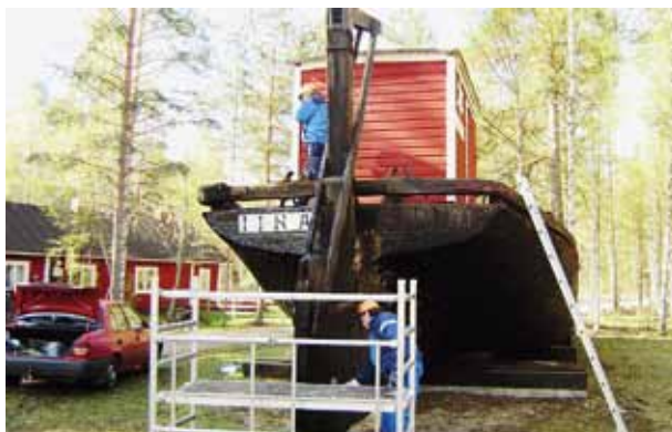
Proomulaiva lina- hytin katto kunnostettiin. Proomun alaosa huolto- tervattiin.
