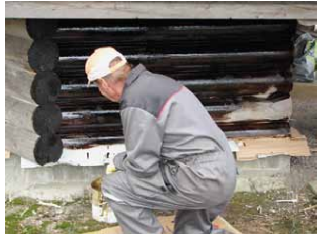
Hirsipinta suojattiin tervaamalla.
