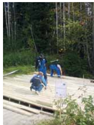
Kangaslammmin ulkoilureitin sillan kansi uusittiin.
