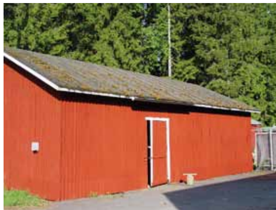
Varaston ulkoverhous kunnostettiin.
