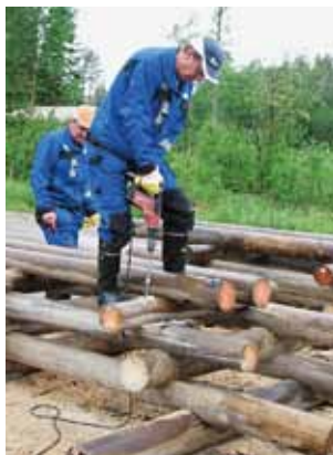
Hirsarkkuisen laiturin teossa päästiin kokeilemaan hirsityötaitoja käytännössä. Alustavat työt tehtiin mitoituksineen ja salvoksineen maalla.
