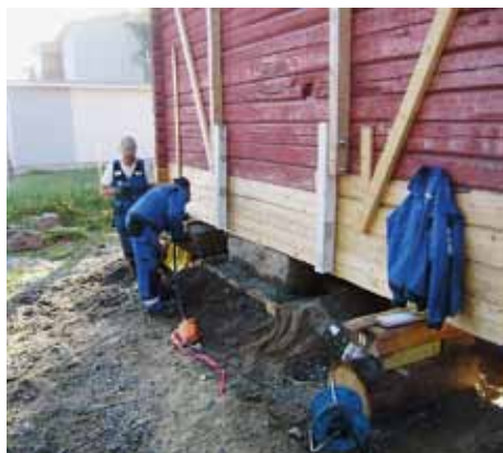
Puistolan päiväkodin aitta korotettiin alkuperäiseen korkeuteensa alahirsiä lisäämällä. Työn valmistuttua rakennus maalattiin keittomaalilla ja piha-alue siistittiin.
