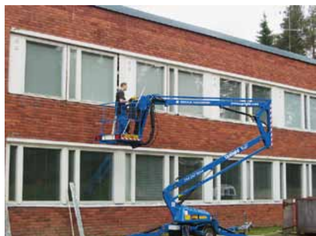
Ikkunatiivisteiden poistaminen oli työlästä. Ylemmän kerroksen kohdalla työ tehtiin nostolavalta.
