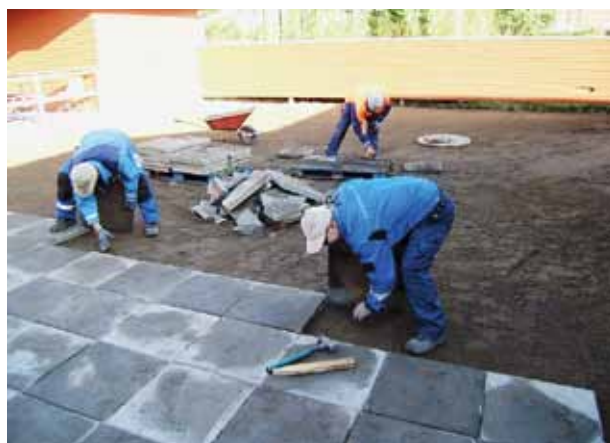
Pihalaatoituksen tekoa. Kaivon ympäristön viimeistely on tarkkaa työtä.
