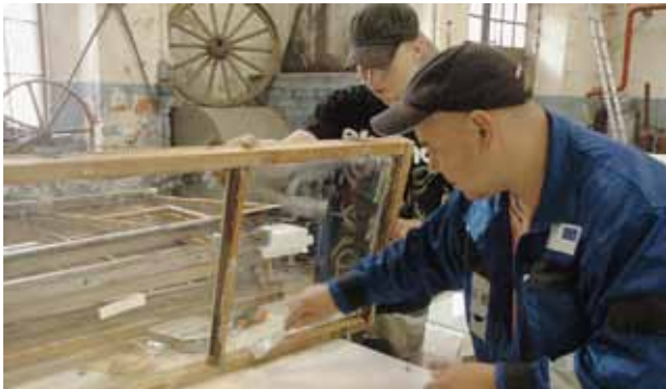
Ikkunoiden kunnostaminen tehtiin sisätiloissa, jonka jälkeen ne asennettiin paikoilleen
