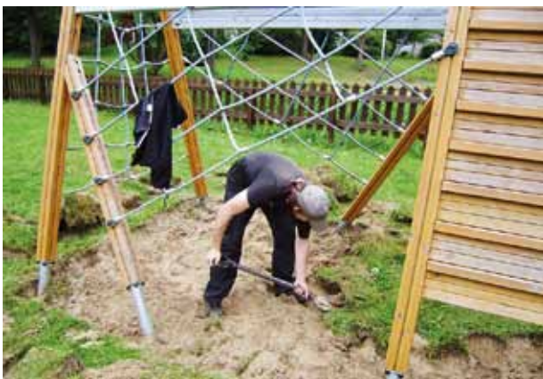
Leikkivälineen alustaa työstetään turvamaton laittamista varten.
