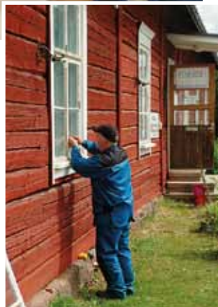
Ikkunoiden kunnostaminen tehtiin sisätiloissa, jonka jälkeen ne asennettiin paikoilleen
