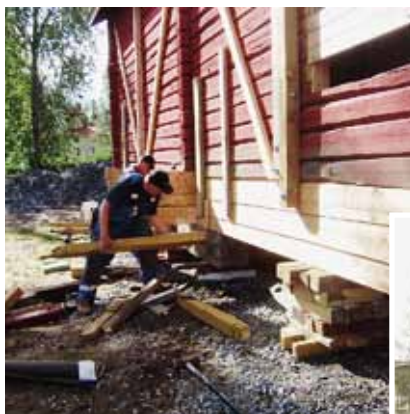
Puistolan päiväkodin aitta korotettiin alkuperäiseen korkeuteensa alahirsiä lisäämällä. Työn valmistuttua rakennus maalattiin keittomaalilla ja piha-alue siistittiin.
