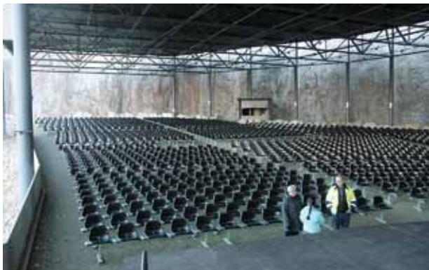
Louhosareenan järjestely- ja siistimistyöt työllistivät erityisesti alkukesästä.
