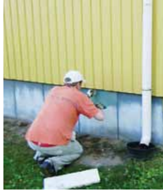
Kurjalan koululla tehtiin ulkomaalaustöitä.
