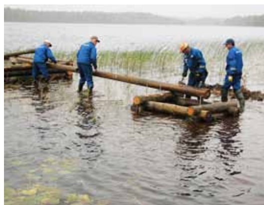
Hirsarkkuisen laiturin teossa päästiin kokeilemaan hirsityötaitoja käytännössä. Alustavat työt tehtiin mitoituksineen ja salvoksineen maalla.
