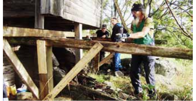
Tuulimyllyn kunnostustyöt Haalanmäellä aloitettiin. Mylly tuettiin kengitystä varten.
