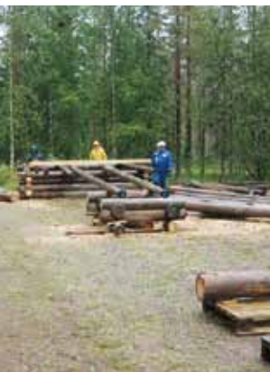
Hirsarkkuisen laiturin teossa päästiin kokeilemaan hirsityötaitoja käytännössä. Alustavat työt tehtiin mitoituksineen ja salvoksineen maalla.
