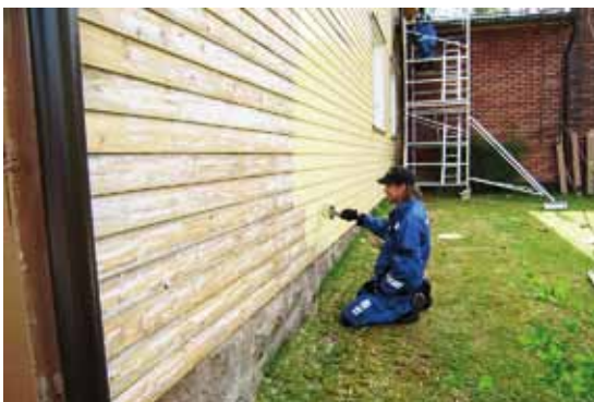
Kunnantalon julkisivu maalaus loppusuoralla.
