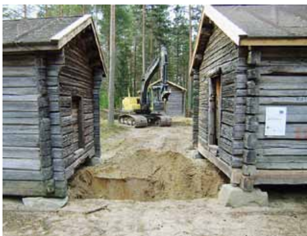
Aittojen sähköistämistä varten vedettiin sähkökaapelit.
