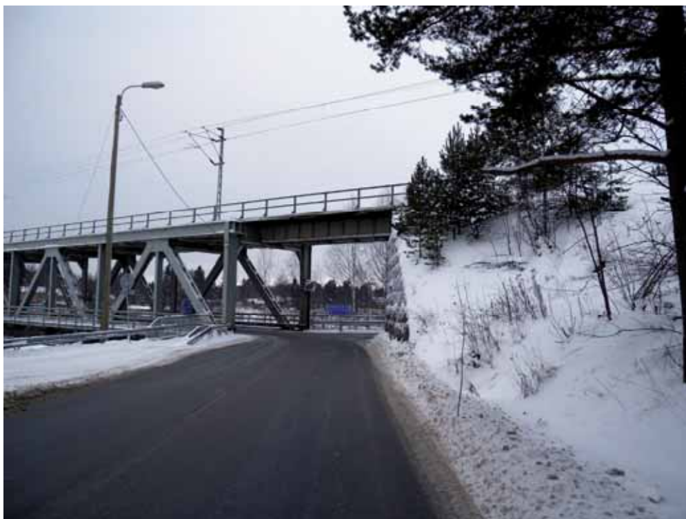
Kuva 26. Aseman sillalla näkemät ovat huonot ja kevyen liikenteen ylityskohdat puuttuvat.
