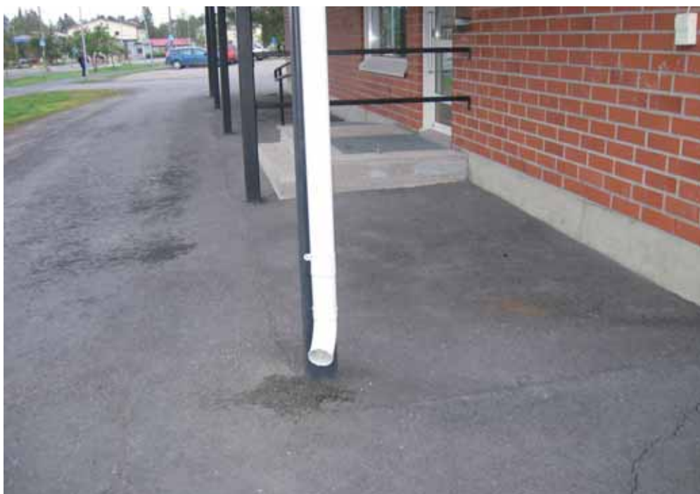
Kuva 31. Kirkkotien varressa olevien liikekiinteistöjen sadevedet ohjataan nykyisin kulkuväylälle.
