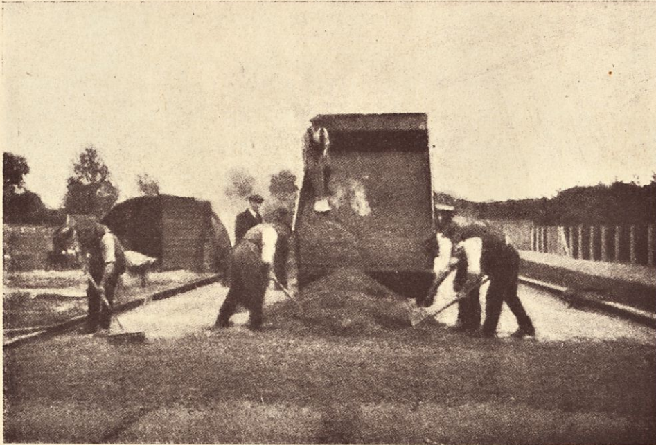
Asfaltväg under utförande
