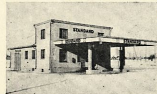
Kemi Tornion aukean laidassa Puh. 375 PTAO
