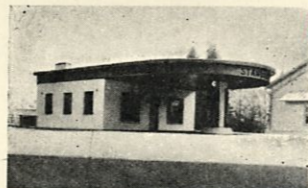
Loimaa Läntisen Valtakadun ja Siltakadun kulmauksessa Puh. 20 PTAO
