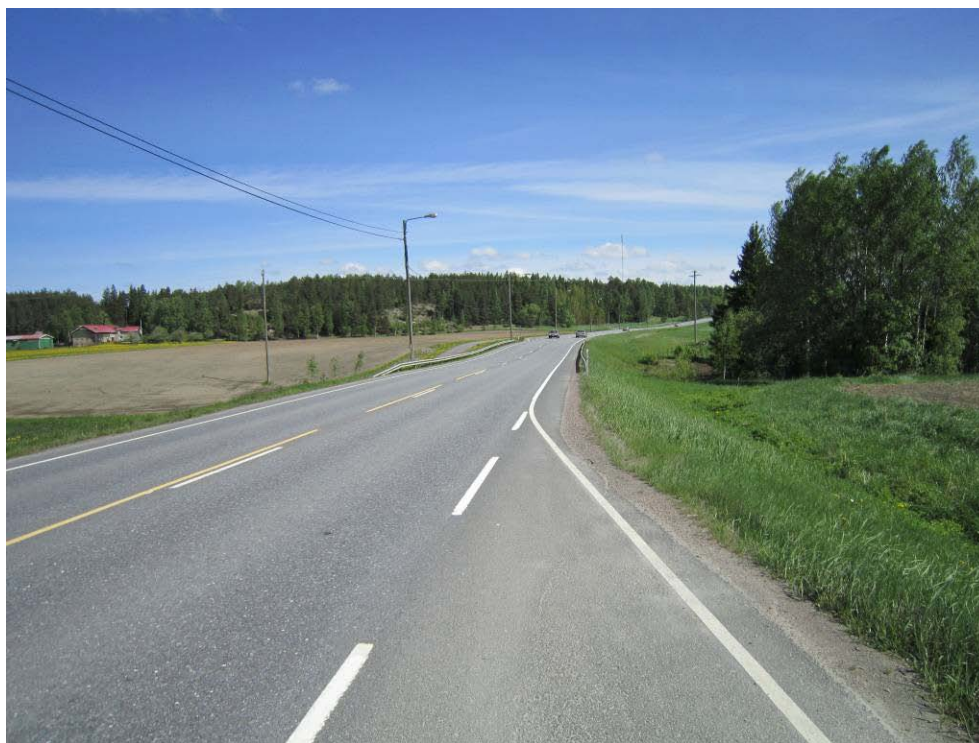
Kuva 42. Yleisnäkymä valtatie 10 tieosalta 4.
