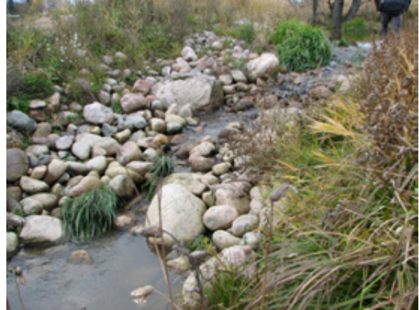
Pienen ojan pohjapato. Niitä voi olla uomissa useita peräkkäin niin, että muodostuu pienehköjen altaiden ketju. Kuva: Anni Karhunen
