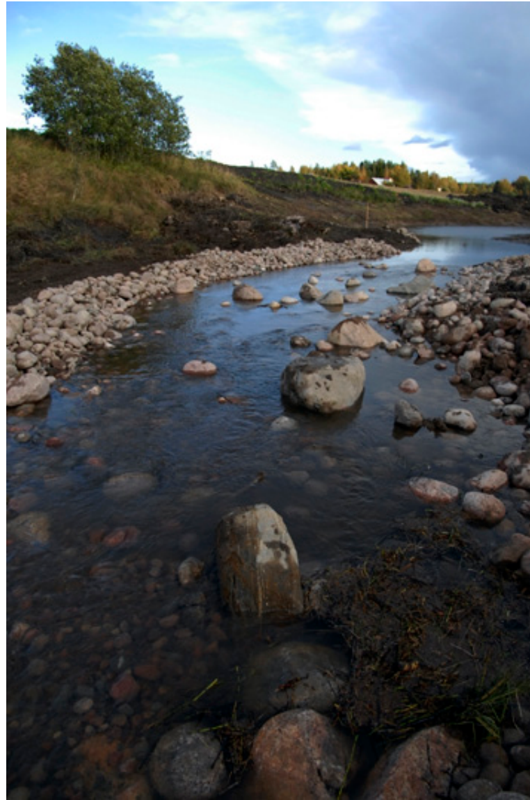
Pohjapato, joka on tehty kalojen kulkua silmälläpitäen loivaksi ja uoman suuntaan pitkäksi. Kuva: Jussi Aaltonen.
