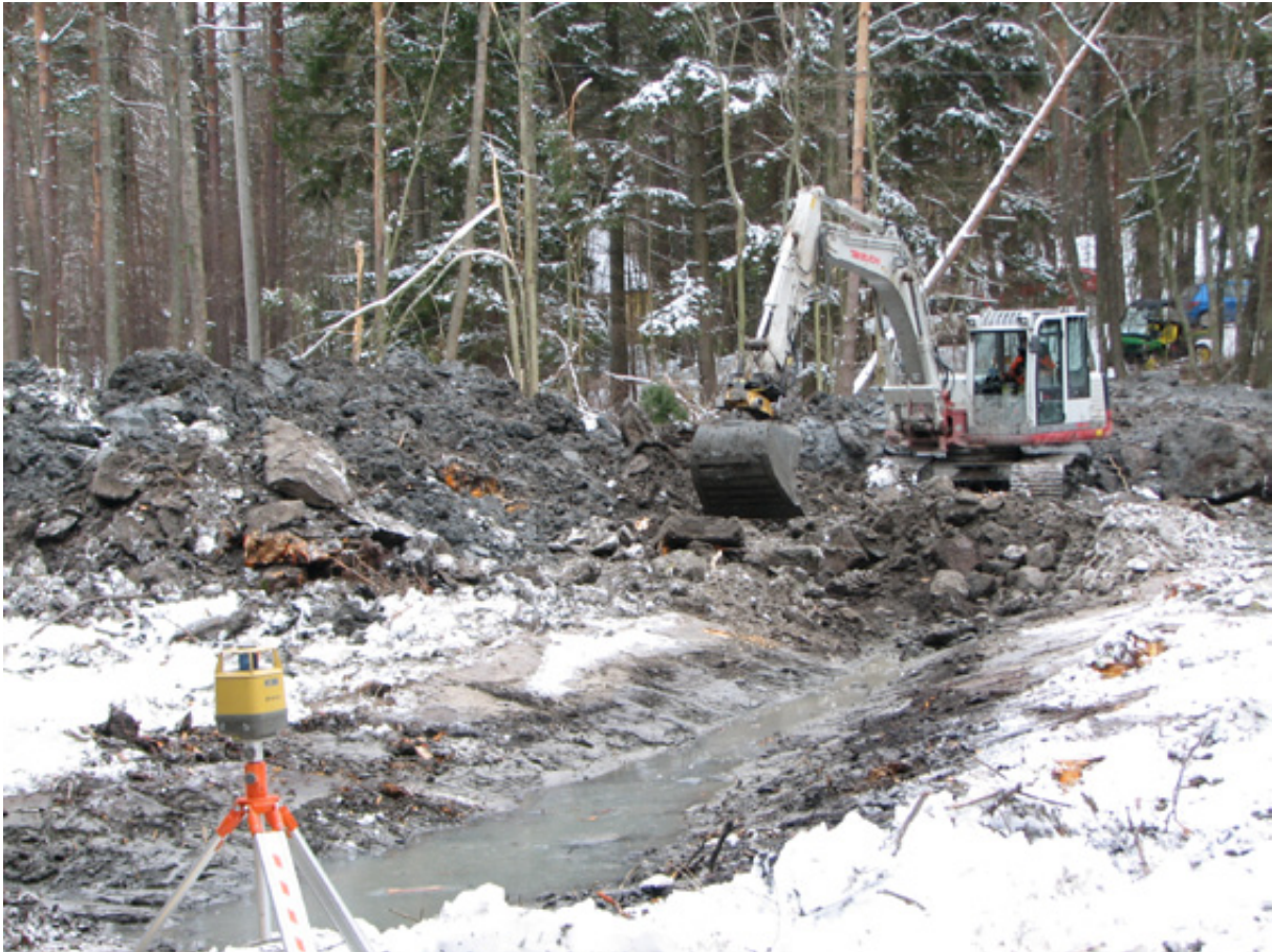
Talvi on hyvä aika kosteikkojen rakentamiseen, sillä vettä liikkuu vähän. Maastomittauksia tarvitaan rakentamisessa mm. veden noston vaikutusalueen määrittämiseen. Kuva: Anni Karhunen.
