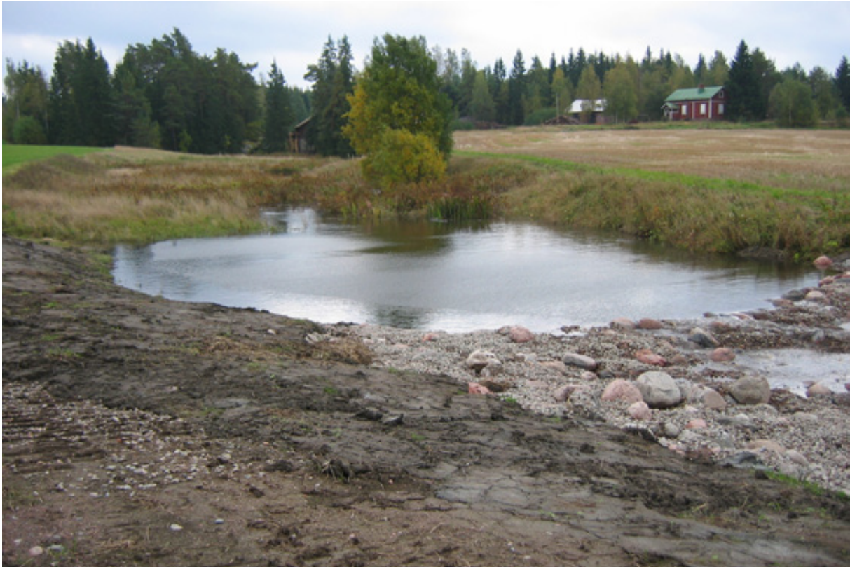
Kosteikko voidaan toteuttaa patoamalla uomaan allas, jolloin virtaus hidastuu ja ainakin osa kiintoaineesta ehtii laskeutua. Altaan ympäristöön kasvit leviävät yleensä yhdessä kesässä, vaikka rakentamisen jälkeen reunat ovatkin lähes paljaita. Kuva: Anni Karhunen.
