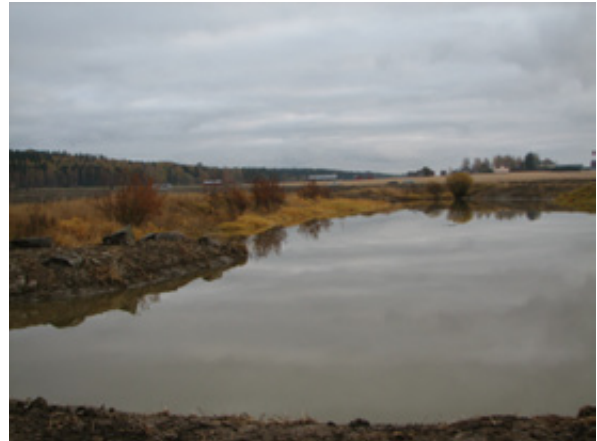
Laskeutusallas voi olla yksinkertainen muotoiltu allas. Sitä voidaan käyttää myös kasteluveden varastointiin. Kuva: Anni Karhunen
