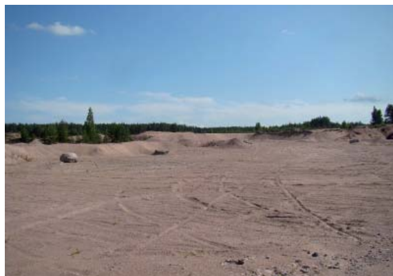
Kuopan 96 alueella maisemointityöt ovat laajalla alueella kesken.
