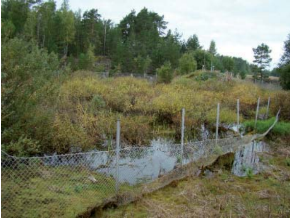
Vedenottamon välittömässä läheisyydessä sijaitsevat lammet ja kosteikot tulee täyttää.
