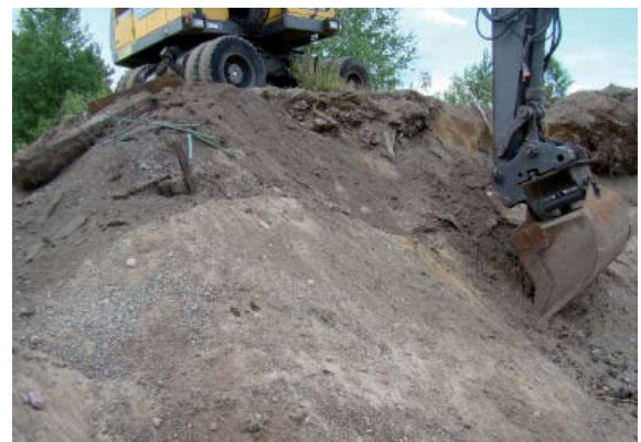
Kuopassa I on paikoin roskaista täytemaata.
