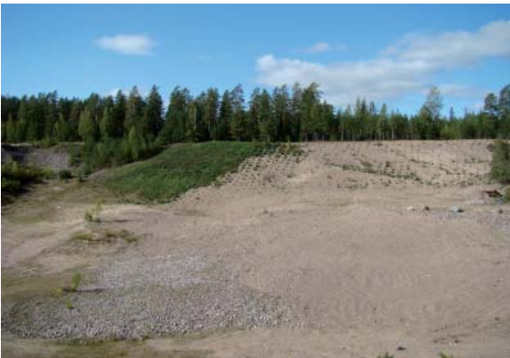
Kuopan 7 rinteille on paikoin levitetty pintamaata, jolloin kasvillisuus on levinnyt hyvin.
