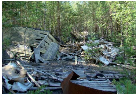
Kuopan 4 alueelle on tuotu paljon rakennusjätettä ja muuta romua.
