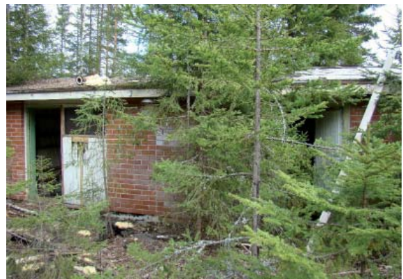
Takaliston kuopassa 2 sijaitsevan vedenottamon ympäristö tulisi siivota ja rakennuksen ovet lukita.
