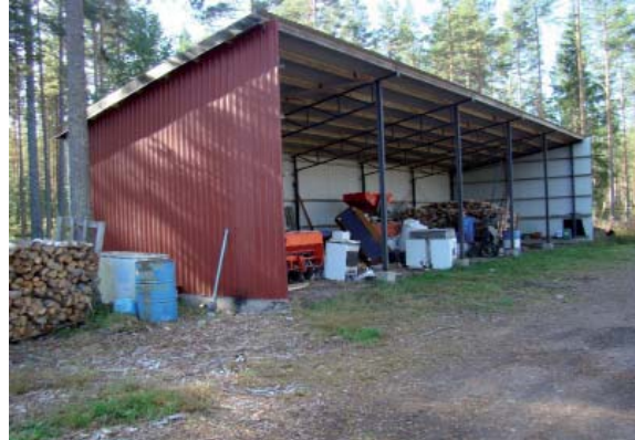
Kuopan 12 vieressä olevassa varastorakennuksessa on säilytyksessä paljon pohjavesialueelle kuulumatonta tavaraa.
