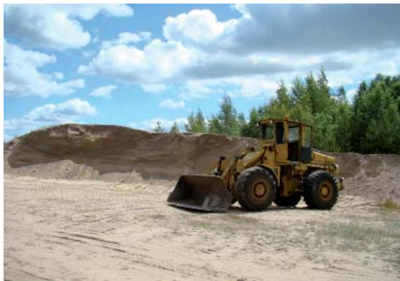
Ottoseinä/vaastokasa kuopan 2 alueella.
