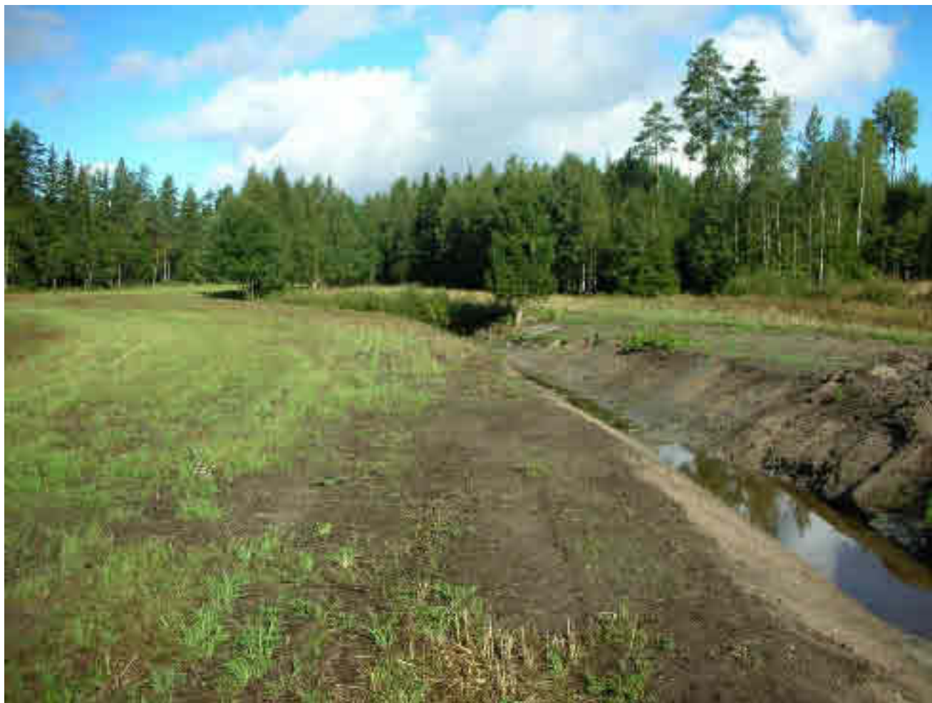
Perattu oja. Tässäkin tapauksessa alivesiuoma, tulvatasanteet ja reunojen loivennus olisivat voineet olla luonnonmukaisempi ratkaisu. Kuva: Ritva Kempainen
