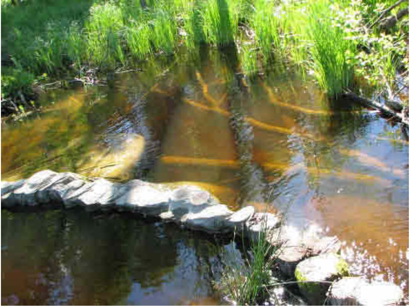
Veden virtausta hidastamaan ja ohjaamaan riittävät joskus puupaalutkin. Kuva: Anni Karhunen
