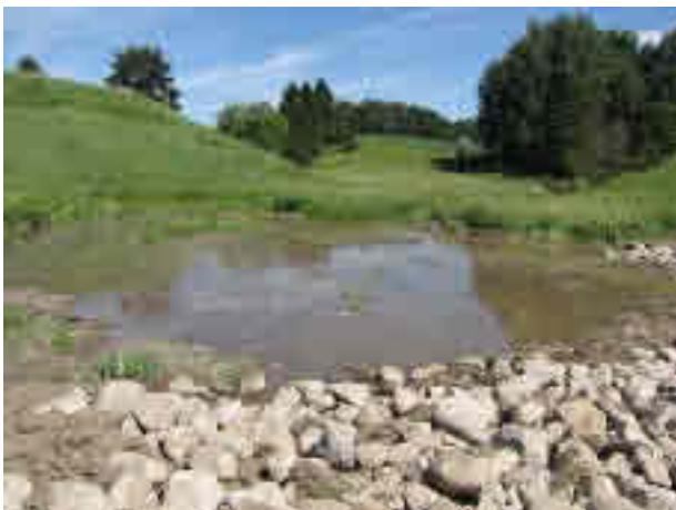
Pienimuotoinen pohjapato sopii esimerkiksi ojiin tehtäviin peräkkäisten altaiden välille. Kuva: Eriika Lundström
