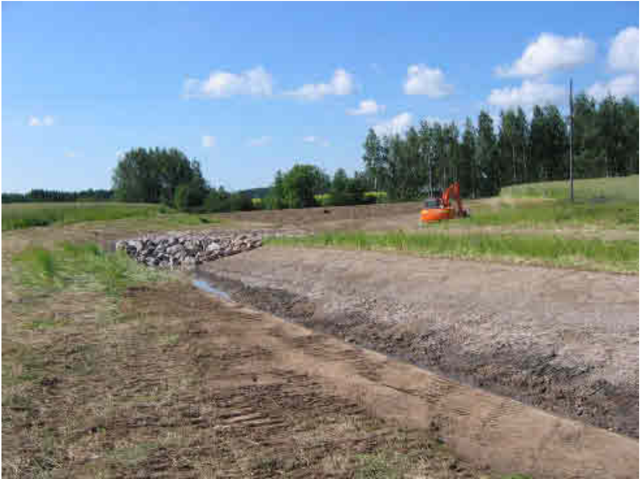
Kosteikko voidaan tehdä patoamalla oja. Työ on hyvä tehdä mahdollisimman kuivana aikana. Taustalla toisessa padossa näkyy ylivuotoputki, joka voi olla tarpeellinen, jos arvioidaan että vesi tulee muuten menemään padon yli ja rikkomaan rakenteita. Kuva: Anni Karhunen
