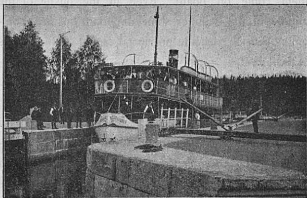
S/s Heinävesi II in the Pilppa canal
