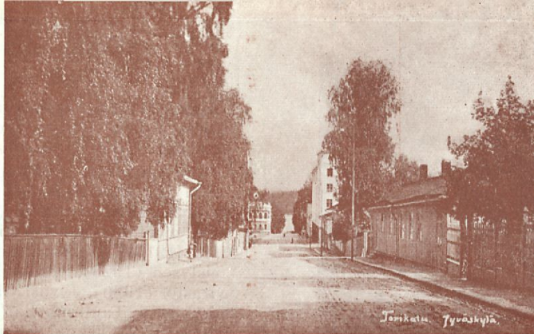
Viihtyisä katukuva. — En tilltalande gatubild. — Anziehendes Strassenbild. — A Typical Street.
