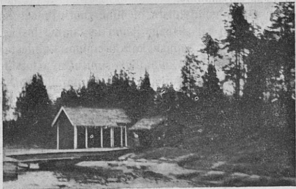
Tornion silta, odotus- ja tavarahuone.
