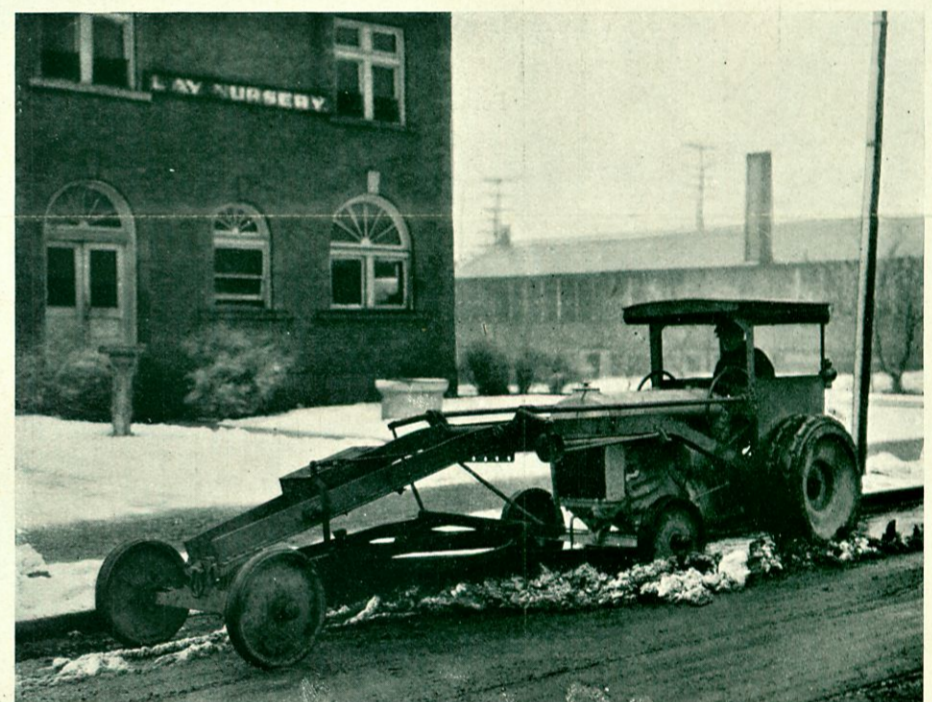
Väghyveln avlägsnar bäst snön från jämna gator.
