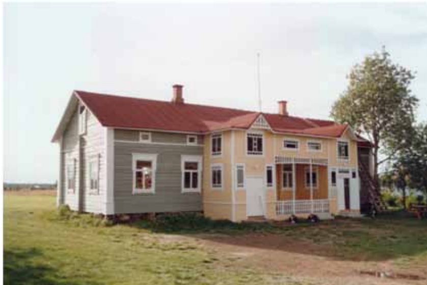
Kuvat 8 ja 9. Kairalan Marttiin talo remontissa ja sen jälkeen. Kuvat: Kari Tallavaara.
