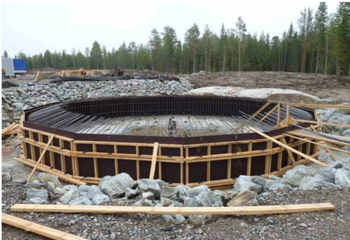
Kuva 3: Tuulivoimala on hyvin suuri rakenne. Esimerkiksi sen perustuksiin menee noin 600 m 3 teräs betonia. Myös asennuskenttä ja muu voimaloita varten rakennettava infrastruktuuri muuttaa alueen luonnonympäristöä suuresti varsinkin herkällä lakialueilla. Kuva: Timo Jokelainen.
